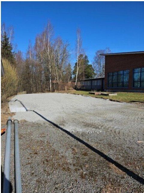
Työmaan työnjohdon ja sosiaalitilojen pohjat tehty
