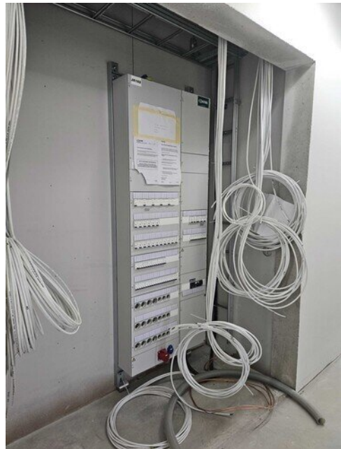
Sähkökeskukset paikoillaan
