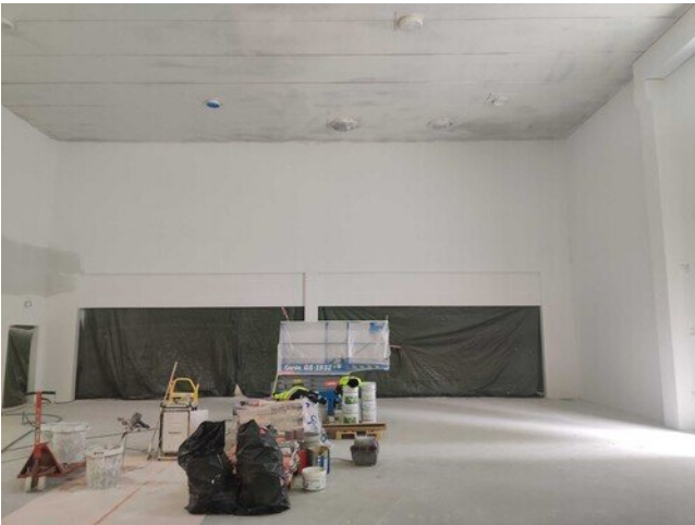
Liikuntasalin tasoitetyöt käynnissä
