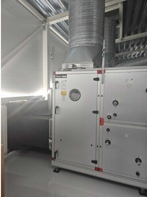
Eristykset aloitettu iv-konehuoneessa
