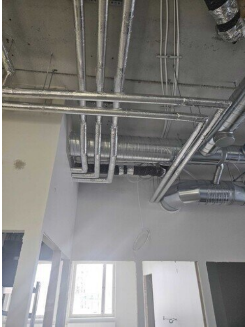
Putkia eristetty teknisen työn siivessä
