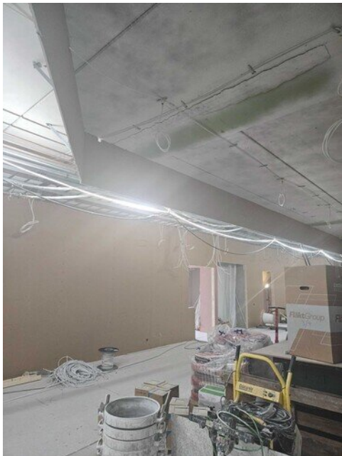
Alakaton otsaa tehty 2. kerroksessa
