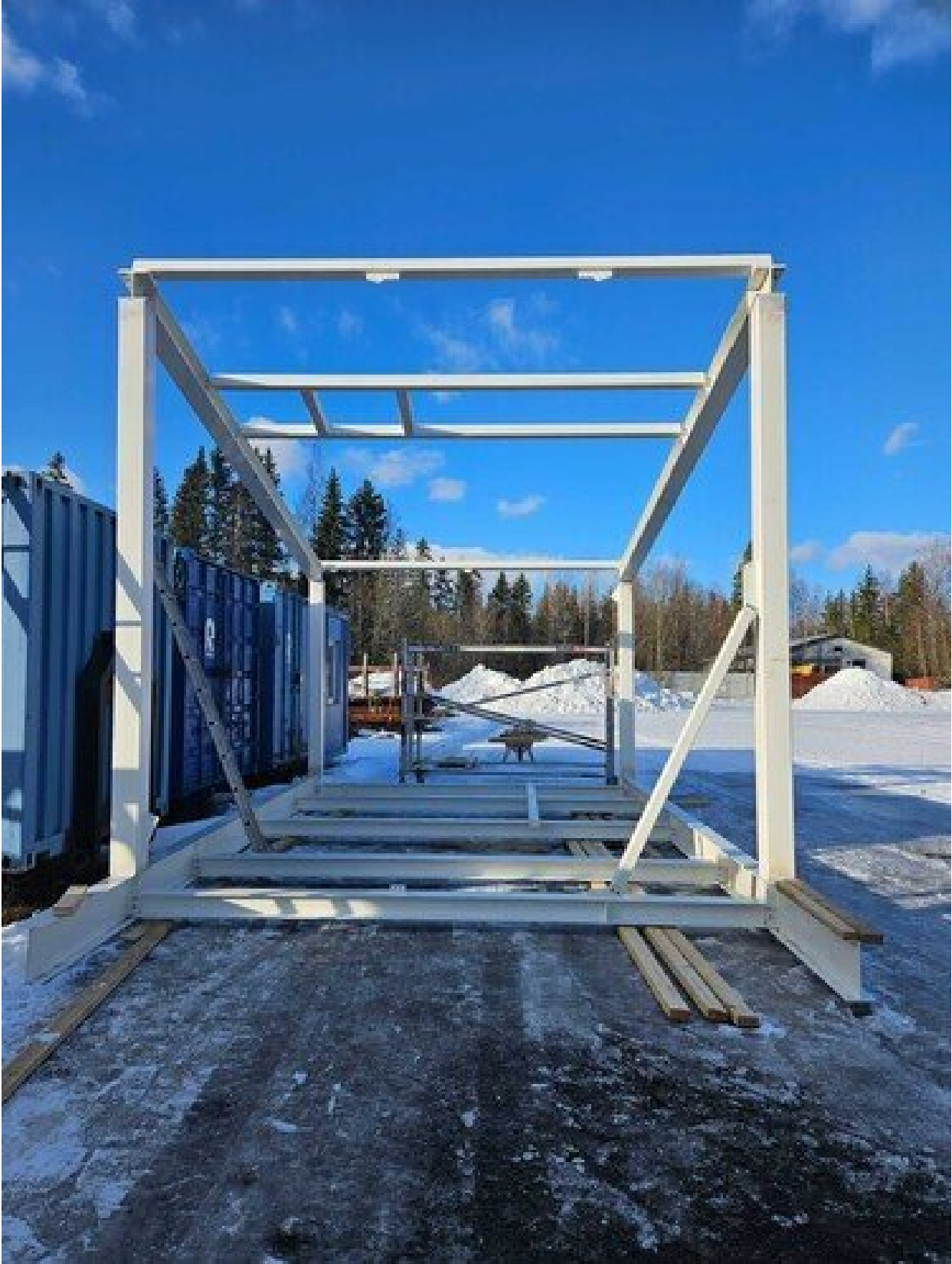
Iv-konehuoneen runko kasattuna
