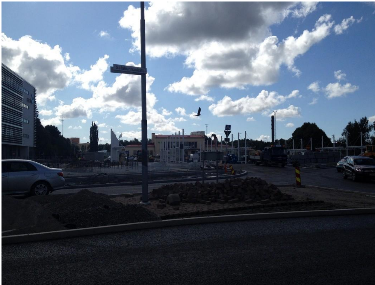
Porin matkakeskuksen rakennustyömaa elokuussa 2017
