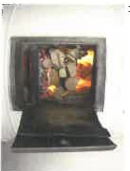
7. Puiden lisääminen laskeutuneelle hiillokselle. Veto säädetään suuremmalle ja palamisen annetaan jatkua voimakkaana (muistettava kuitenkin kohtuus ja hallittavuus).
