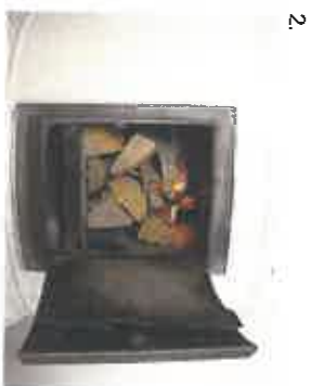
2. Tulisijana on 1950-luvun pönttöuuni, jonka pesään puut ladotaan linnavasti: suuret alle ja pienet päälle, pinnalle runsaasti syykkeitä.
