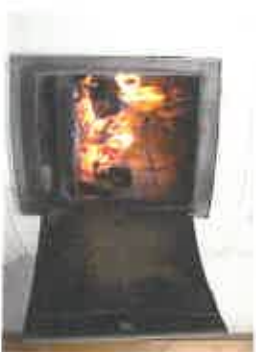
5. Hiilloksen syntyvaihe. Vetoiluukkuja pienennetään tässä vaiheessa.
