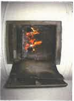
6. Hiilospalamisen vaihe. Veto säädetään huomattavasti pienemmälle.
