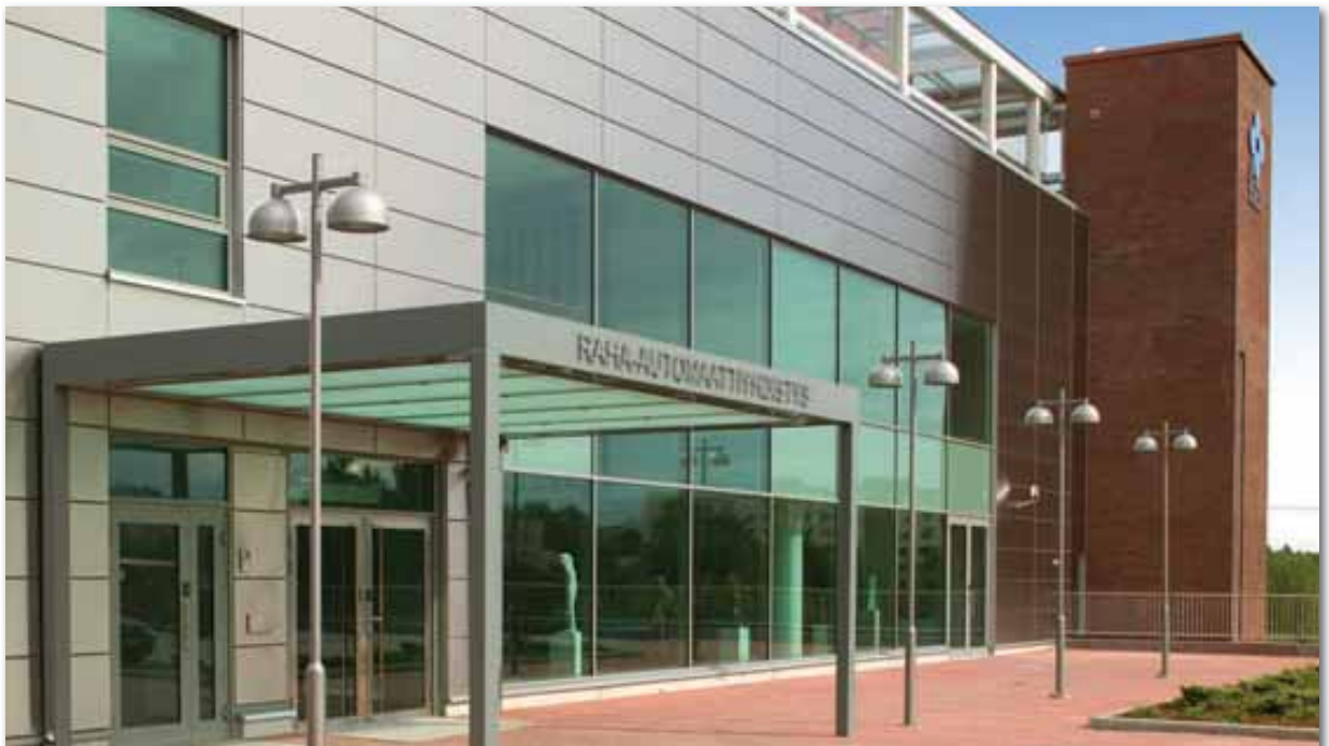
Rakentaminen. Raha-automaattiyhdistyksen pääkonttori Espoossa vuodelta 2004. Talossa ruostumatonta ja haponkestävää terästä.
