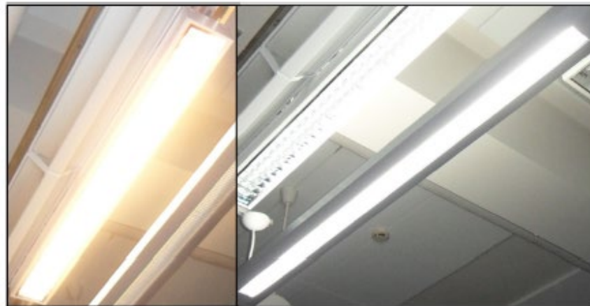
Kuva 2.15. Lämpimän valkoinen (3000 K) loisteputki vasemmalla ja kylmän valkoinen (6500 K) loisteputki oikealla.
