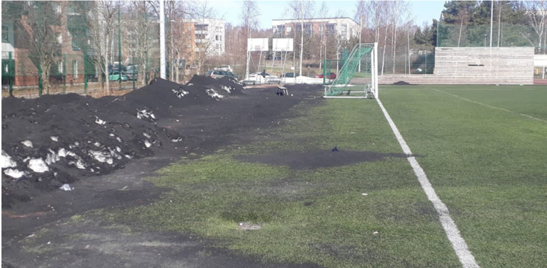
Tekonurmikentän lumikasoihin on kerääntynyt valtavat määrät kumirouhetta. Kuva: Erika Sainio, SYKE
