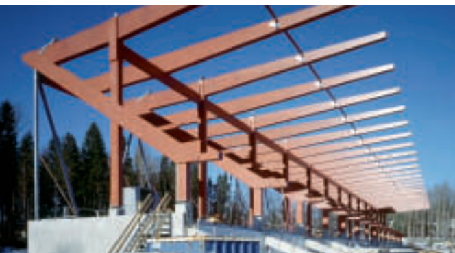
ISS-Stadion Vantaa. Kerto- ja liimapuurakenteita.
