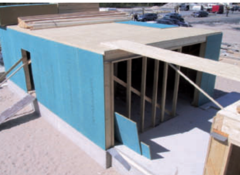
Rakennusten tuulensuojalevyt ovat usein kuitulevyä.
