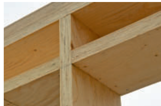
Omakotitalon laajennus Kerto-rungolla.
