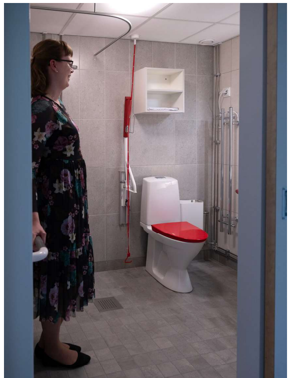
■ Annika Granqvist som jobbar på Hagaro visar upp en av de nyrenoverade toalettterna. Flera detaljer i rummet är röda, eftersom det är en färg som är lätt att uppfatta för den som ser dåligt. En annan nyhet är lampan som tänds när dörren öppnas. FOTO: NIKLAS TALLQVIST
