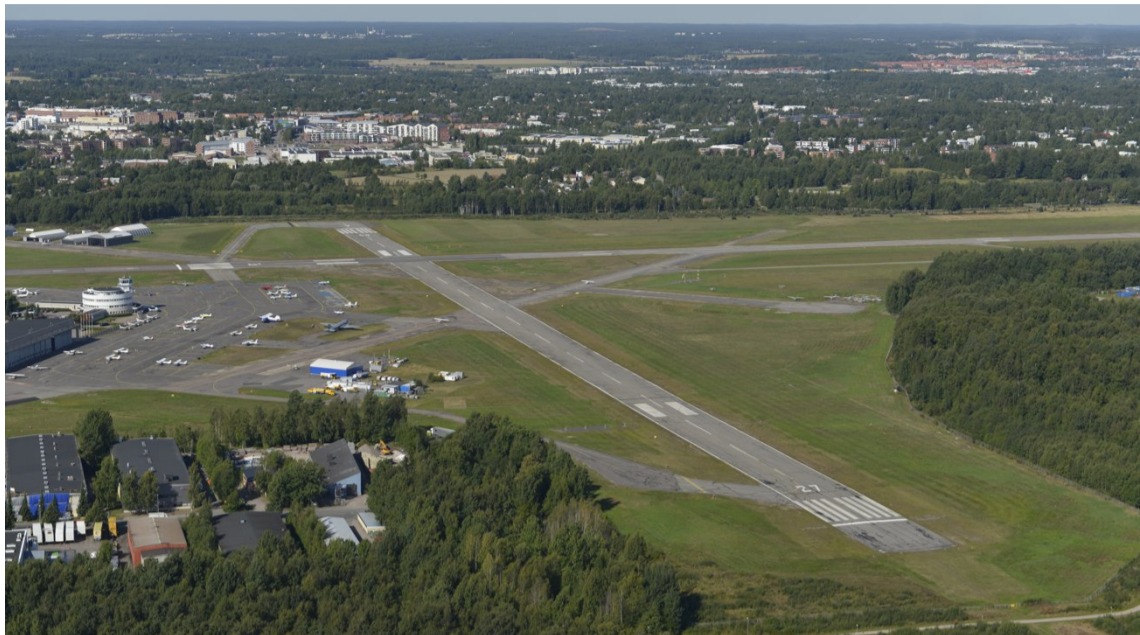
■ När Malms flygplats blir bostadsområde ska grundberedningen göras med material som ersätter den klassiska och klimatvidriga kalk-cementblandningen. Det kan halvera utsläppen. FOTO: FASTIGHETSKONTORET I HELSINGFORS
