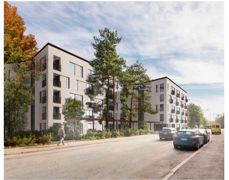
■ Nya Folkhälsanhuset i Haga byggs delvis i trä med solpaneler och bergvärme. FOTO: KUVATOIMISTO KUVIO OY
