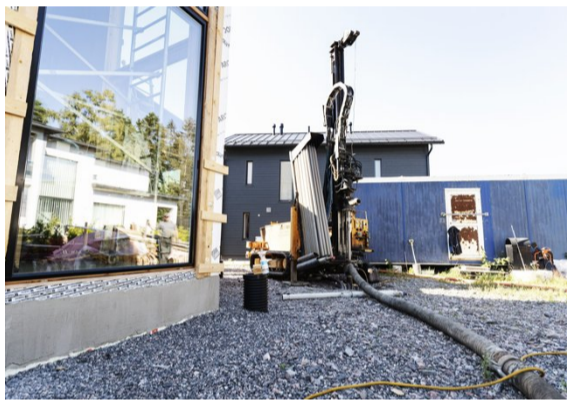
■ Ett husbolag i östra Helsingfors låter installera värmepumpar. Det är ett sätt att frigöra sig från beroendet av fjärrvärme. FOTO: RONI REKOMAA/LEHTIKUVA
