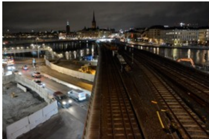
Slussenin eritasoliittymän vuosia kestänyt rakennustyömaa oli yksi kuvauskohteista.
