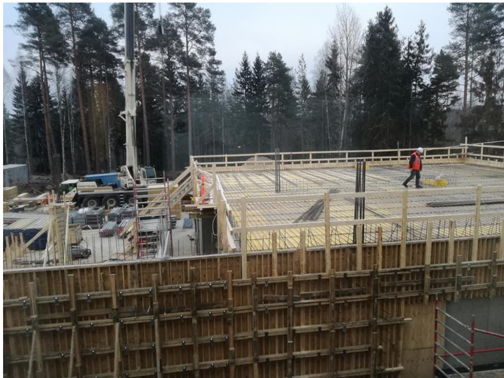
Kuva: Koskenkylän uusi kaksikielinen koulukeskus rakennusvaiheessa 2018
