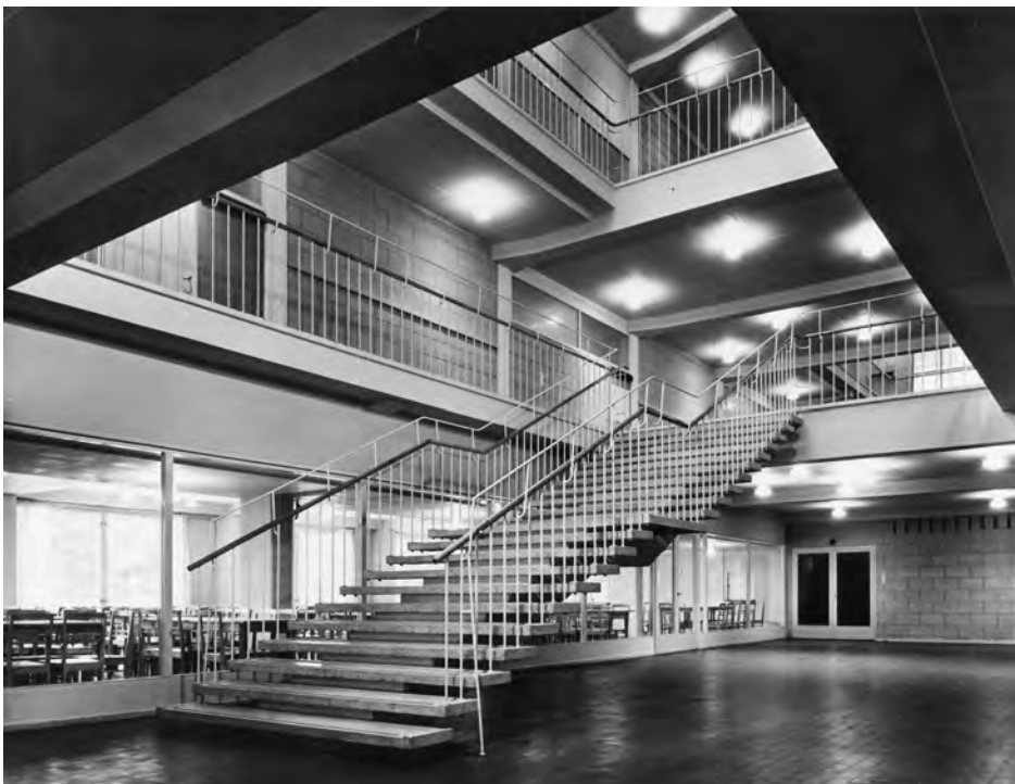
kuva 40 portaikko pohjakerroksesta 1. kerroksen aulaan
