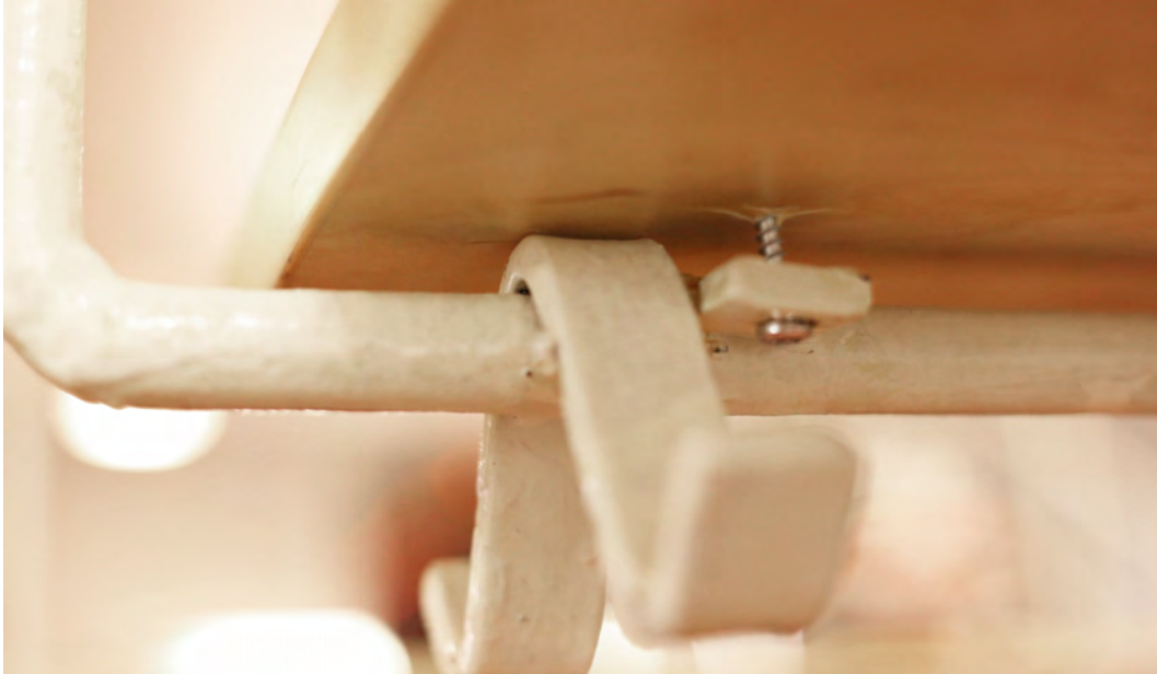
kuva 28; yksityiskohta aulan ripustetun naulakon ylälevyn kiiinnityksestä
