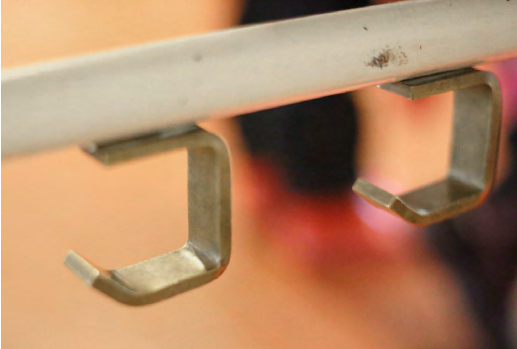
kuva 30; putkinaulakon alaosassa alkuperäiset messinkiset koukut
