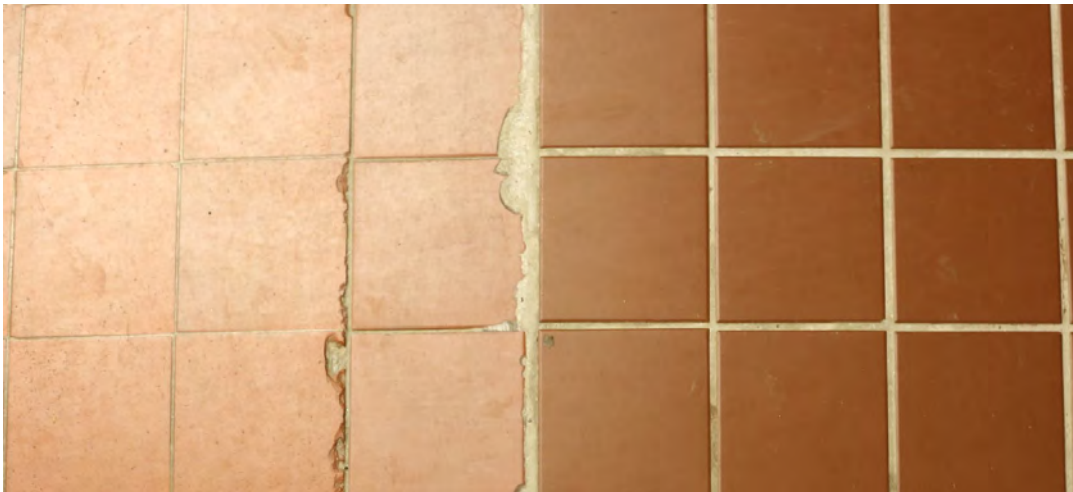
kuva 13; oikealla aulan tiililattiaan tehty invaluiskaus, jonka pinta yksisävyistä klinkkerilaattaa isolla saumalla
