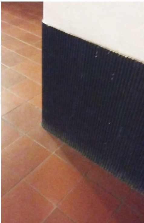
kuvat 19 ja 20: yksityiskohtia tuulikaapin yhteydessä; aulan pilareiden rihlakumiset sokkeliosat, tuulikaapin oven messinkinen vedin, sekä jalopuulistoitus
