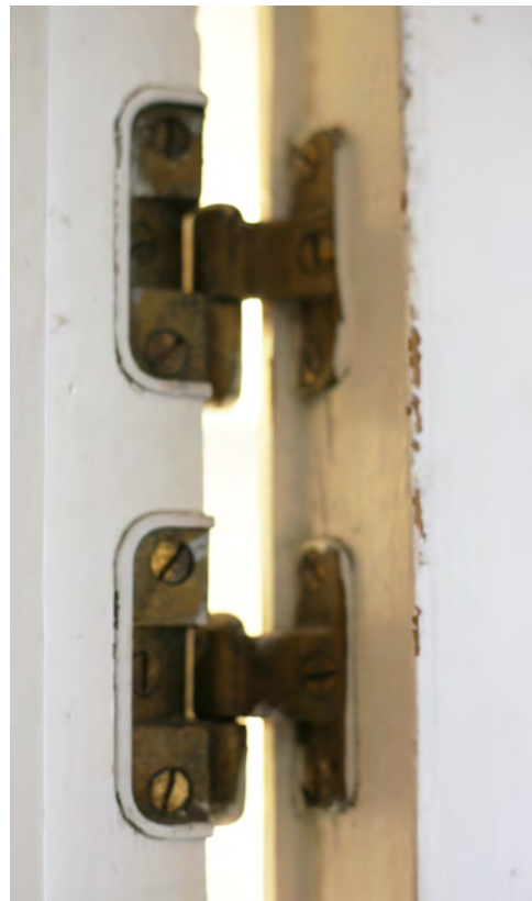
Kuvat 22 ja 23; tuulikaapin puinen sisälaseinä + -ovi, messinkiset saranat alkuperäisillä messinkiruuvikiinnityksillä
