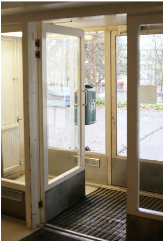
Kuvat 22 ja 23; tuulikaapin puinen sisälaseinä + -ovi, messinkiset saranat alkuperäisillä messinkiruuvikiinnityksillä
