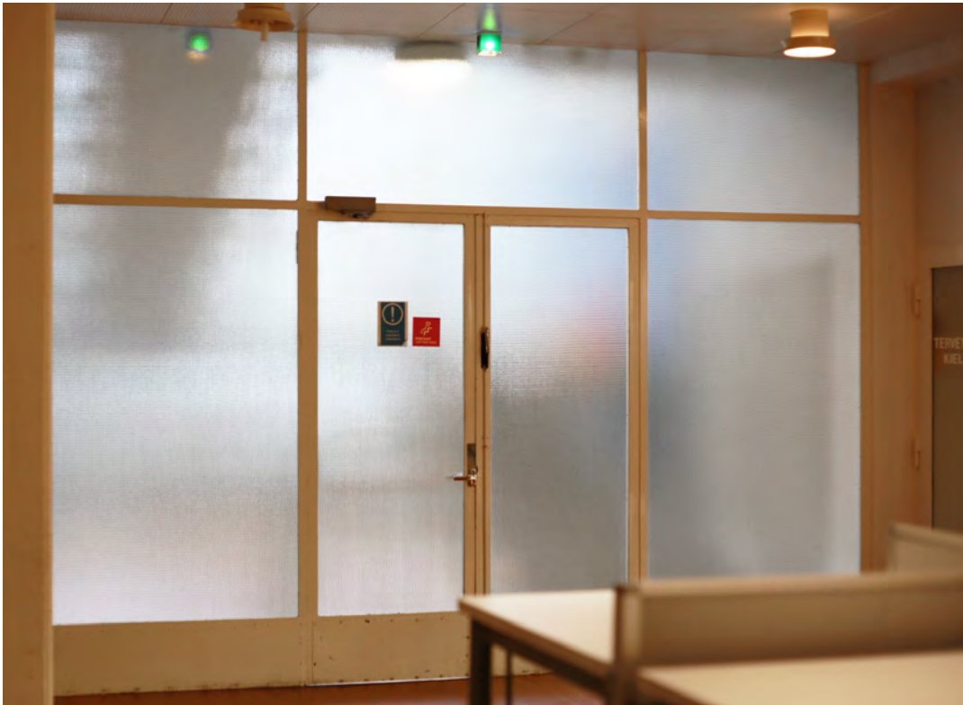
Kuva 21; porrashuoneen teräs-lasiseinä ja ovi
