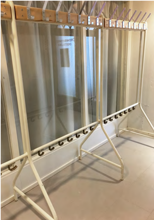
kuva 29; putkinaulakko (yläosan vaatekoukut korvattu uusilla)
