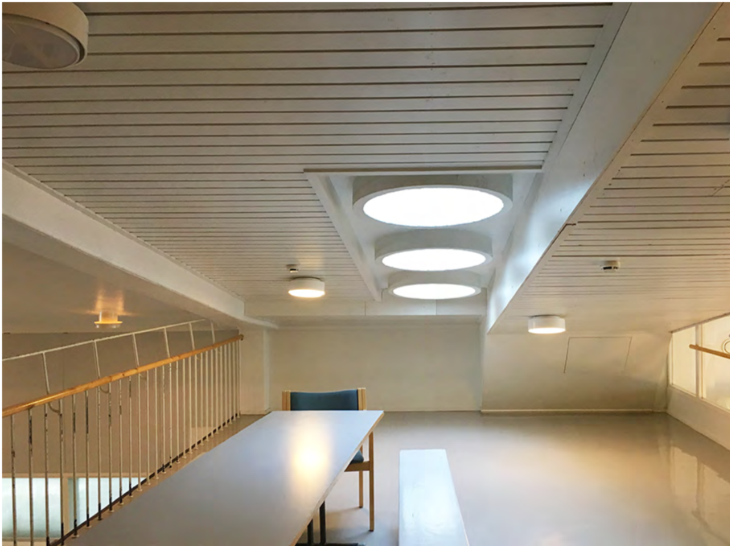
kuva 5; 3. kerroksen porrastasanteen kattoikkunat ja lautaverhoiltu kattopinta (pyöreät valaisimet uusia)
