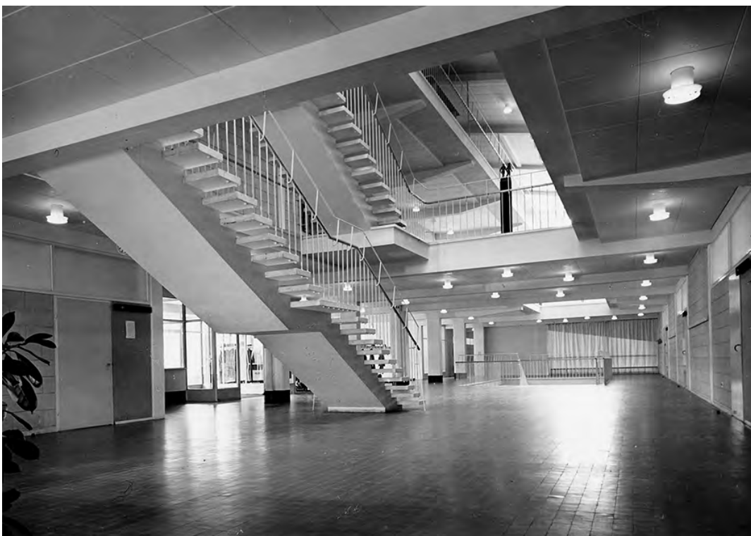
kuva 3; Lohjan lukion portaikkoo
