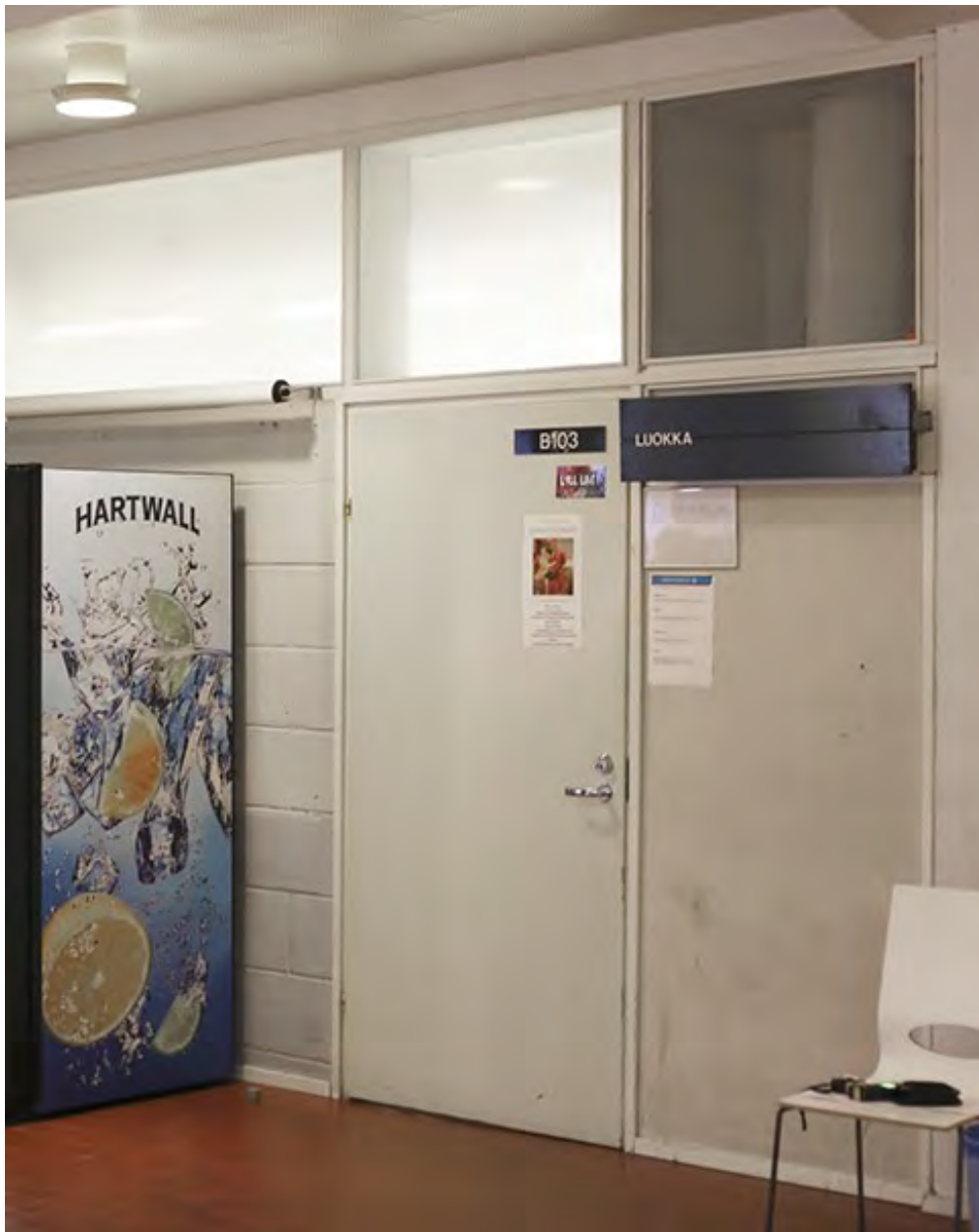
Kuva 17; luokkahuoneen nykyinen sisäänkäynti
