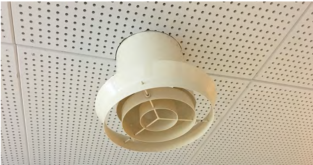
kuva 8; aula- ja käytävätilojen alkuperäinen valaisin
