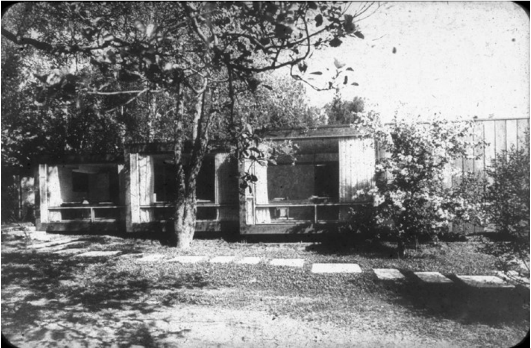
Pihapiiriin, aivan meren rantaan rakennettiin vuonna 1962 ateljeerakennus Ervin toimistoa varten.
