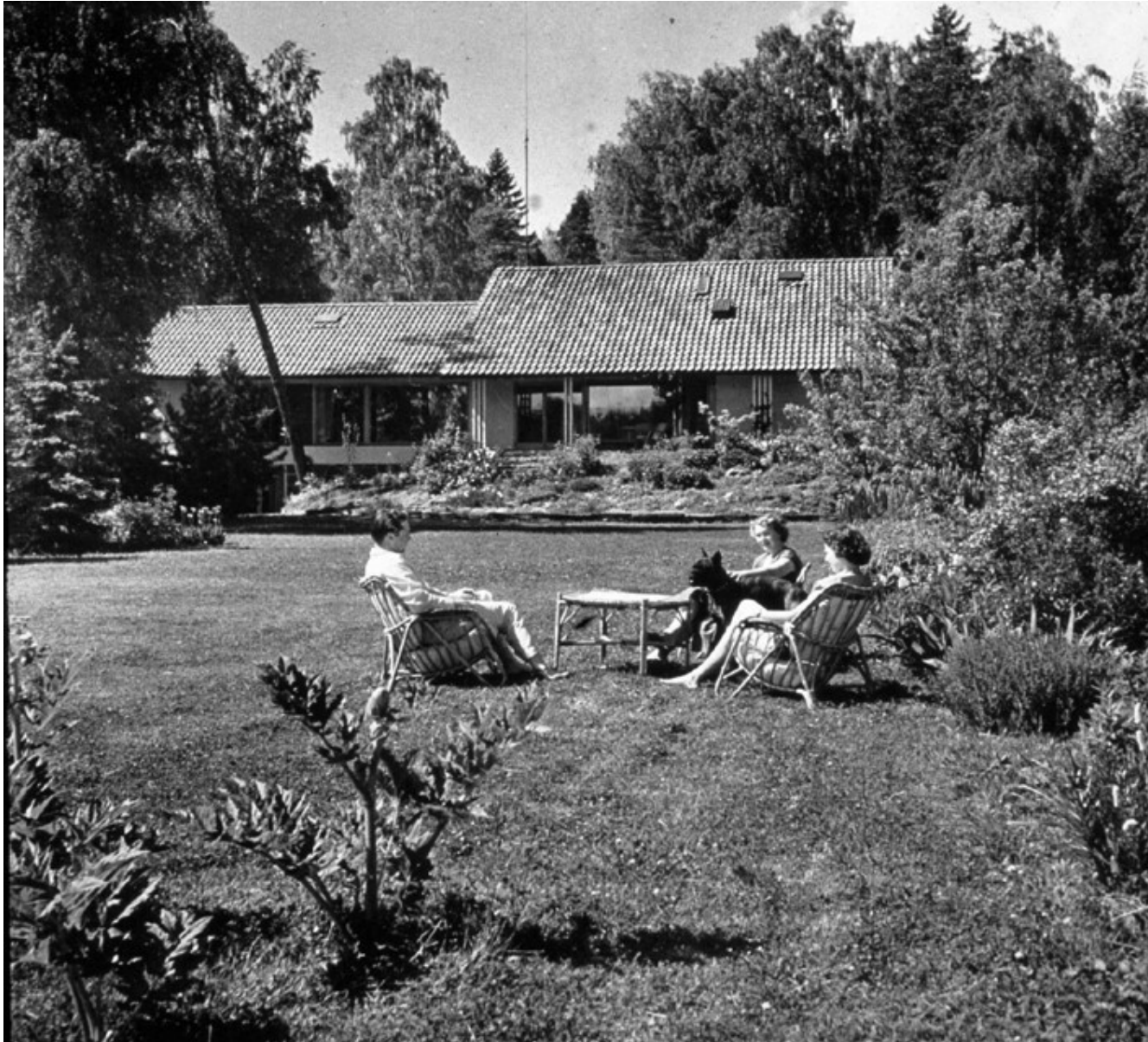
Rakennus on kapearunkoinen ja "läpinäkyvä". Intiimi puutarha jää aitamuurin taakse. Runko pystytettiin seitsemälle teräsputkipilarille, jotka kantavat valmiista osista koottuja välipohjia ja kattoa. Näin rakennus oli helposti laajennettavissa.
