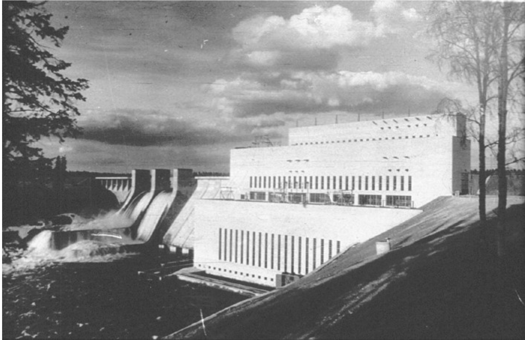
Ervi suunnitteli monumentaaliset Oulujoen voimalaitokset osin jo 1940-luvulla (1941-1957). Voimalaitokset asuinalueineen kertovat arkkitehtuurin kehityksestä 1940-luvun romantiikasta 1950-luvun modernismiksi. Kuvassa Pyhäkosken voimalaitos (1944-49).
