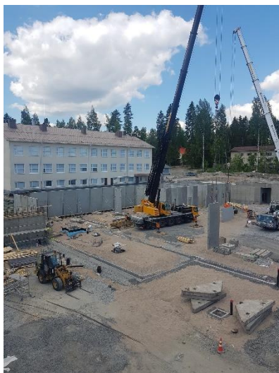
Kuva 2. Liikuntahallin elementtiasennus käynnissä.
