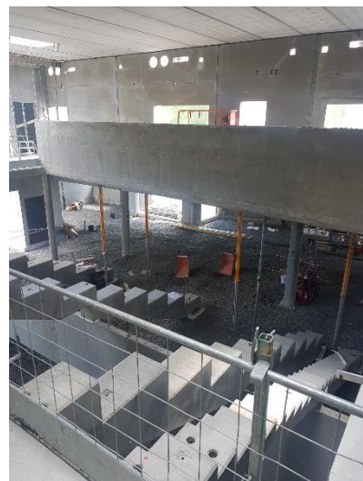
Kuva 3. Koulun aulan katsomorakenteita asennettuna.
