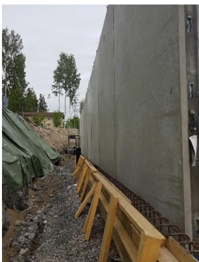
Kuva 1. Liikuntahallin maanpaineiseinän elementit asennettuna.
