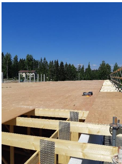
Kuva 2. DA-osan vesikatolle vaneriasennus käynnissä.
