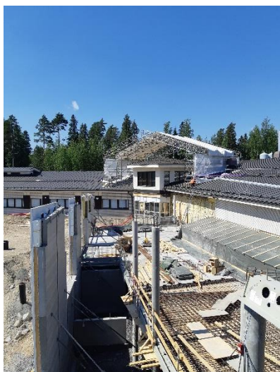
Kuva 1. Sääsuoja tulossa c-osan vanhan sisäänkäynnin päälle.
