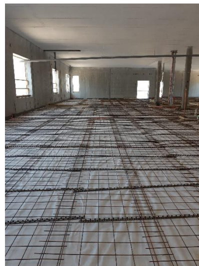
Kuva 3. DA-osa raudoitukset pintalaatan valua varten.
