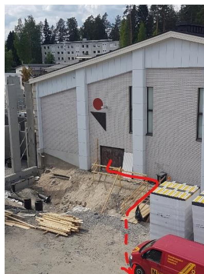
Kuva 3. Liikuntasalin hätäpoistumistie ja reitti työmaa-alueella.
