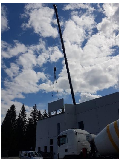
Kuva 2. DA-osan viimeisten elementtien asennus käynnissä.
