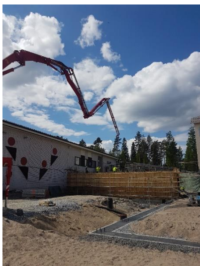
Kuva 1. Koulun ja uuden liikuntahallin yhdystunnelin rakenteiden valutyöt käynnissä.
