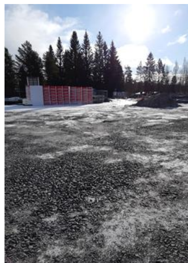
Kuva 3. Parkkipaikan pohja valmiina
