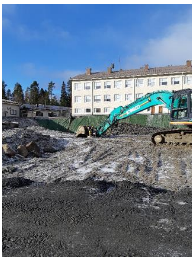
Kuva 2. Liikuntahallin anturoiden pohjatyöt käynnistyvät.
