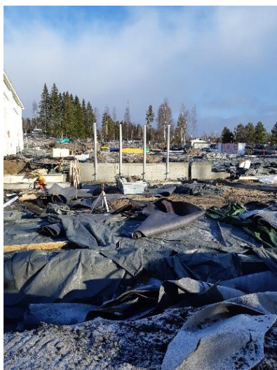
Kuva 1. D-osan ensimmäiset teräspilarit pystyssä.
