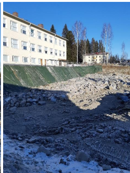
Kuva 3. Liikuntahallin pohja louhinnan jälkeen.
