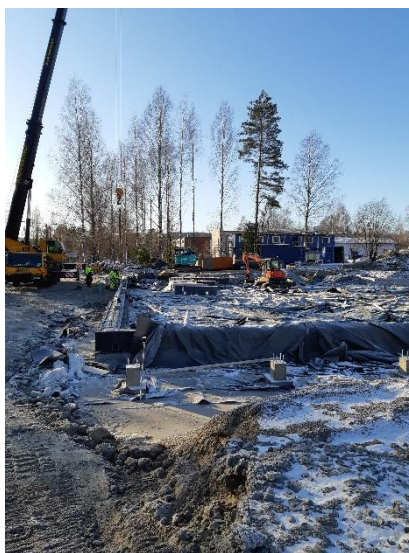
Kuva 2. Sokkelikuorielementtien asennus D-osalla.
