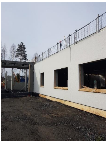
Kuva 1. Haavistontien puoleista ulkoseinää.
