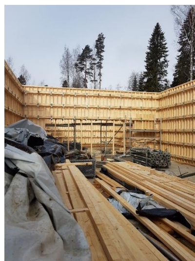
Kuva 3. Liikuntahallin väestönsuojan seinämuottien valmistusta.
