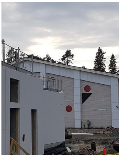
Kuva 2. Uutta koulun ulkoseinää ja vanhaa säilytettävää liikuntasalin ulkoseinää.
