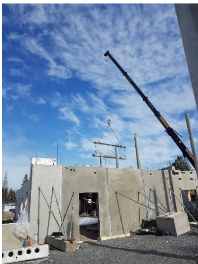
Kuva 1. Väliseinäelementtejä asennettuna.
