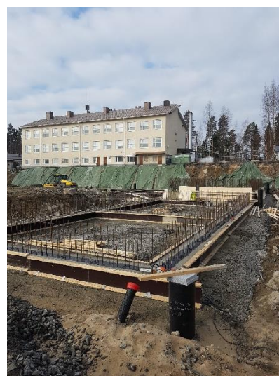
Kuva 3. Liikuntahallin väestönsuojan perustusten työt käynnissä
