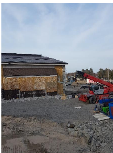
Kuva 2. Vanhan koulun C-osan ulkoseinän kuoren purkutytöt ovat käynnissä. Uusi koulurakennus yhdistyy tällä osalla jo olemassa olevaan osaan.
