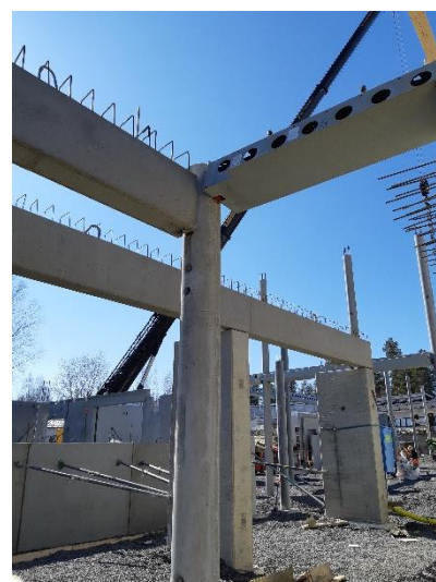
Kuva 3. Koulun ensimmäisen kerroksen elementtirakenteita.
