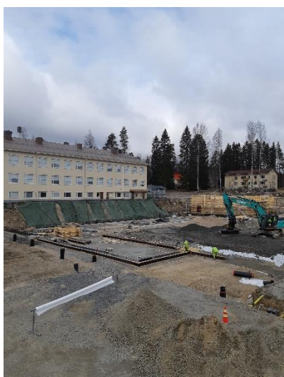
Kuva 1. Liikuntahallin perustusten muottitöitä.
