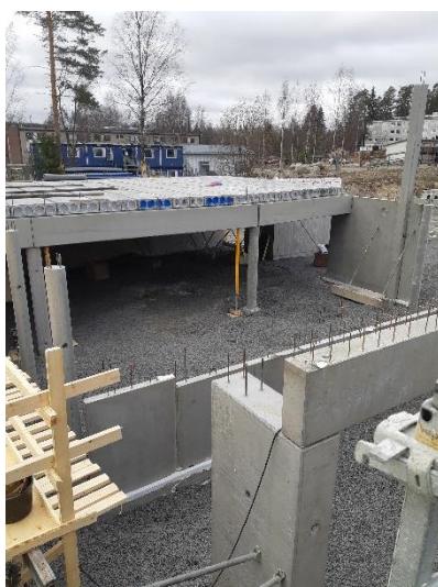
Kuva 2. Koulun aulan katsomon kohdan elementtirakenteita.
