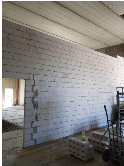
Kuva 2. Väliseinämuuraukset aloitettu D-osalla
