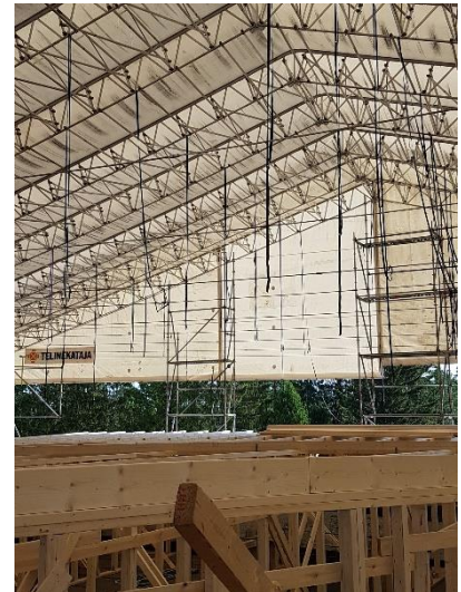
Kuva 3. DB-osan vesikaton puutyöt käynnissä sääsuojan alla
