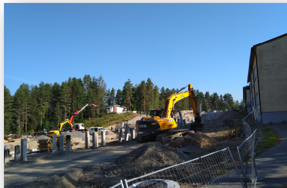
Rakentaminen alkaa (kesä 2019)
