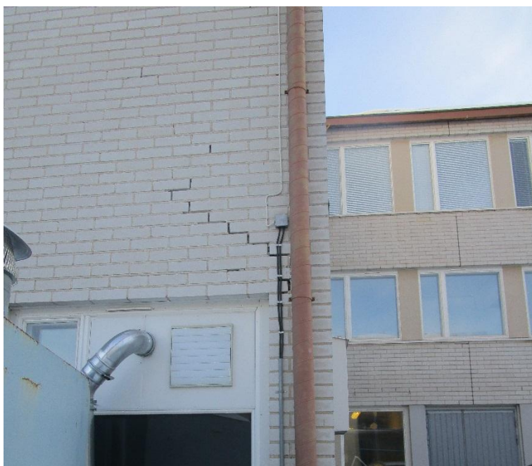
Kuva 3.4 Tiilimuurauksen halkeilua.
