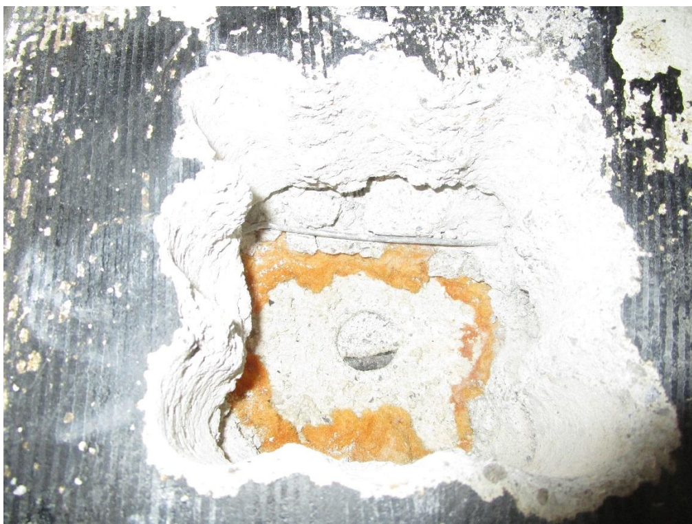
Kuva 3.12 Musiikkiluokan varaston alapohjaan tilaajan toimesta suoritettu rakenneavaus.
