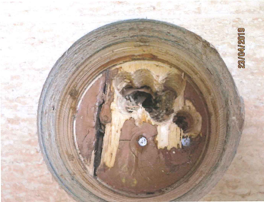
Kuva 3. Materiaalinäyte 2 luokkahuoneen alapohjasta, eristeenä sammalta ja turvetta
