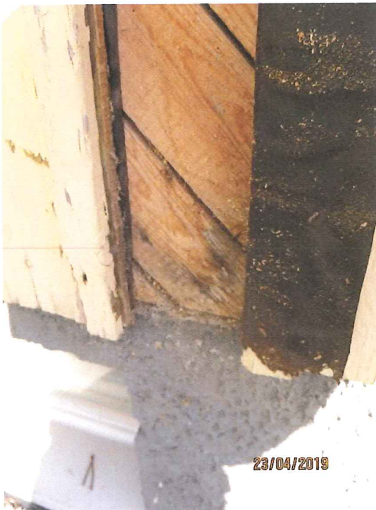
Kuva 5. Ulkoseinän materiaalinäyte (näyte 3) otettiin ulkoa päin.
