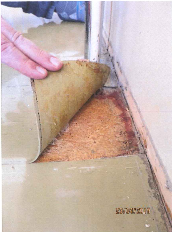
Kuva 7. Näyte 7 puutyöluokan lavuaarin alta lattian purueristeestä.
