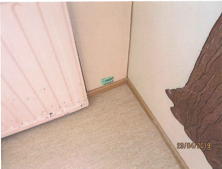
Kuva 2. Materiaalinäyte 1 ulkoseinän lisäeristyksestä luokkahuoneen pihan puoleisesta nurkasta
