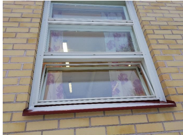
Kuva 6: Ikkunat ja ikkunapellitykset ovat asianmukaisessa kunnossa.
