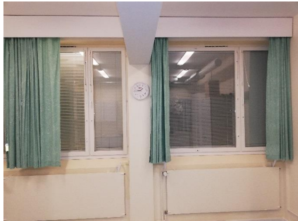
Kuva 15: Tiivistyskorjatun seinän vanhanosan puoleinen seinärakenne.
