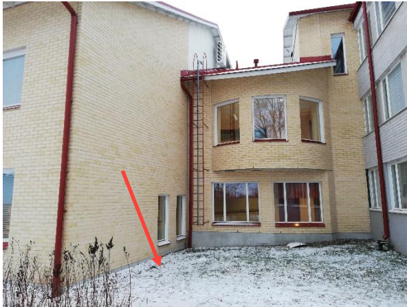
Kuva 5: Maanpintojen kallistukset viettivät paikoitellen rakennukseen päin.
