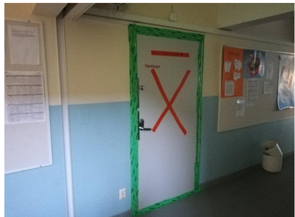
Kuva 24: Vanhalla puolella olevat ovet on tiivistetty ilmapirtausten pääsyn estämiseksi opettajan huoneeseen.
