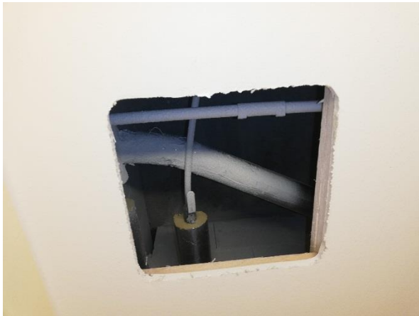
Kuva 18: Avonainen tarkastusluukku.
