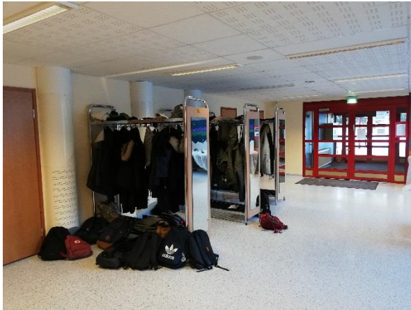
Kuva 16: Alaslasketut sisäkattot ovat kipsilevyrakenteisia.
