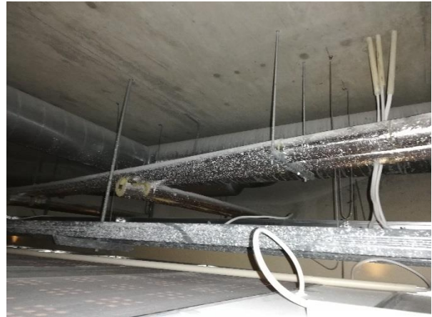
Kuva 17: Sisäkattojen tilat olivat pääosin siistikuntoisia.
