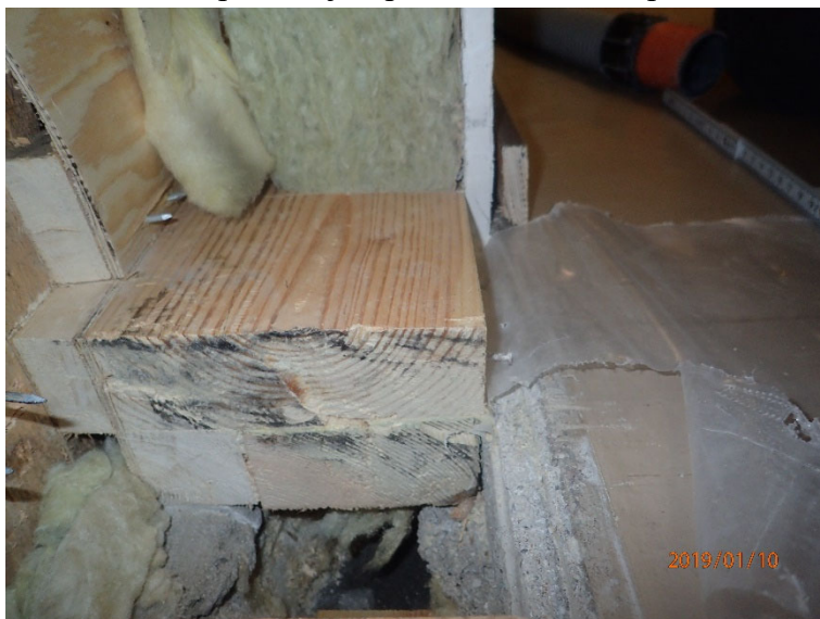
Kuva 12. Kestopuinen alaohjauspuu on nostettu kiilapaloilla toteutettuun korkeuteen. Ratkaisu poikkeaa suunnitelmista.
