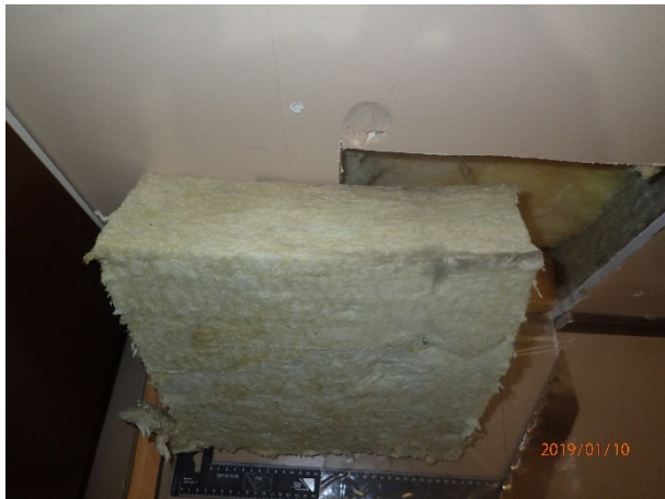
Kuva 4. Ulkoseinän mineraalivilla oli aistinvaraisesti hyväkuntoinen
