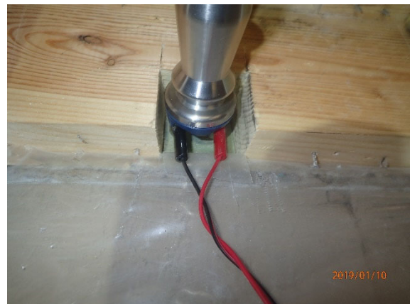
Kuva 10. Ulkoseinän höyrysulkumuovi on taitettu alaohjauspuiden väliin. Alaohjauspuiden välissä mineraalivillakaista
