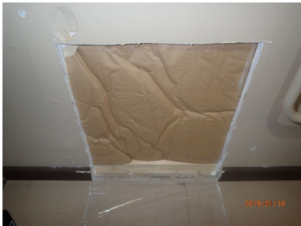
Kuva 3. Kipsilevyn takana höyrysulku ja paperipintainen mineraalivillakerros
