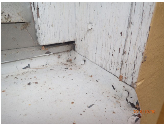
Kuva 18. Vesipellityksien rajapinnat eivät täysin estä veden pääsyä seinärakenteisiin. Pellin reuna tulisi olla ”smyygilaudan” takana.
