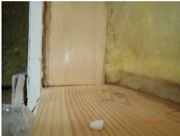
Kuva 5. Alaohjauspuu ja pystyrunko oli aistinvaraisesti hyvässä kunnossa. Pystyrunkona on käytetty ympärihöylättyä 45x95 puutavaraa. Ulompi villa 50 mm on vasten tuulensulkulevyä
