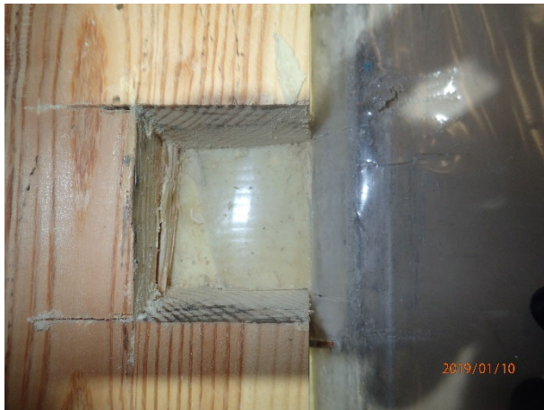
Kuva 10. Ulkoseinän höyrysulkumuovi on taitettu alaohjauspuiden väliin. Alaohjauspuiden välissä mineraalivillakaista
