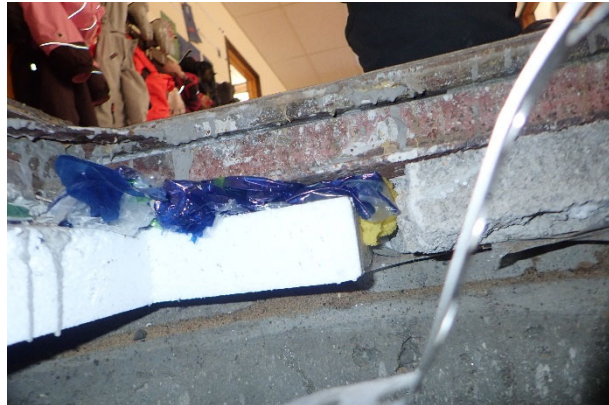
Kuva 23. Alapohjarakennetta.
