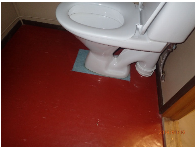
Kuva 31. Paikallisesti korjattu wc-istuimen alusta.
