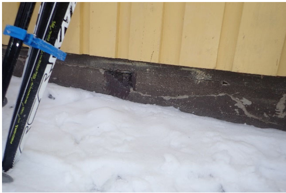
Kuva 17. Perusmuurin vaurioita. Sadevesisysteemin kohdalla sadevesi saattaa kuormittaa perusmuuria ja seinärakenteita
