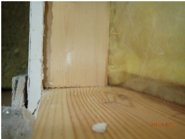
Kuva 5. Alaohjauspuu ja pystyrunko oli aistinvaraisesti hyvässä kunnossa. Pystyrunkona on käytetty ympärihyölytettyä 45x95 puutavaraa. Ulompi villa 50 mm on vasten tuulensulkulevyä
