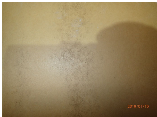
Kuva 21. Mikrobinäyte 1/2019 otettiin kipsilevyn kartongista tummentuman kohdalta. Tummentuma on todennäköisesti syntynyt kipsilevyn valmistuksen yhteydessä.
