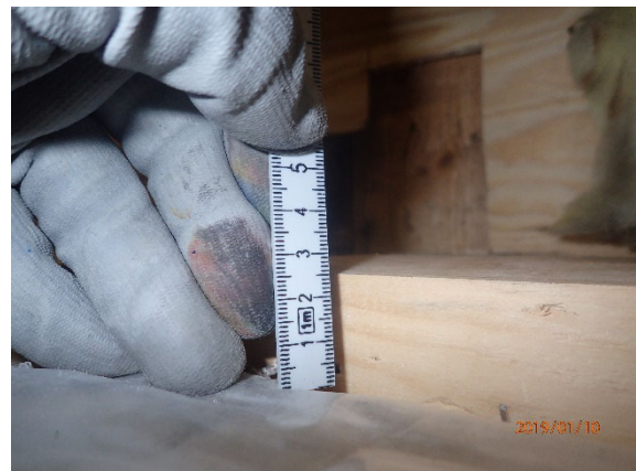
Kuva 13. Perusmuurin päälle sijoitettu kermieriste, kestopuisia korotuspaloja ja mineraalivillaa.
