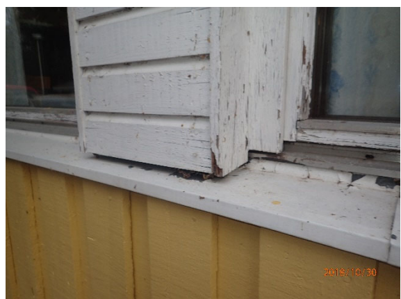
Kuva 18. Vesipellitysten rajapinnat eivät täysin estä veden pääsyä seinärakenteisiin. Pellin reuna tulisi olla ”smyygilaudan” takana.
