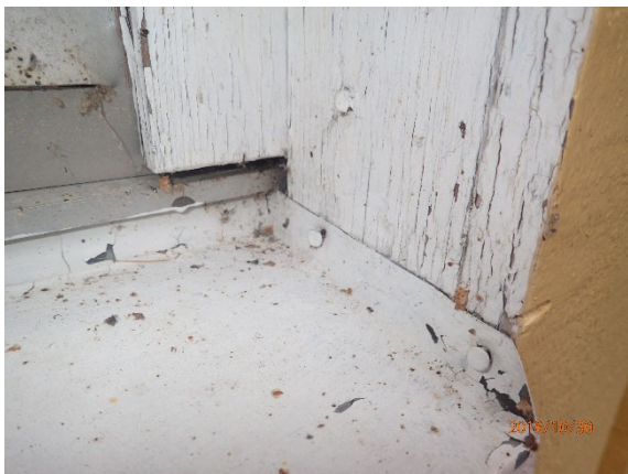
Kuva 18. Vesipellitysten rajapinnat eivät täysin estä veden pääsyä seinärakenteisiin. Pellin reuna tulisi olla ”smyygilaudan” takana.
