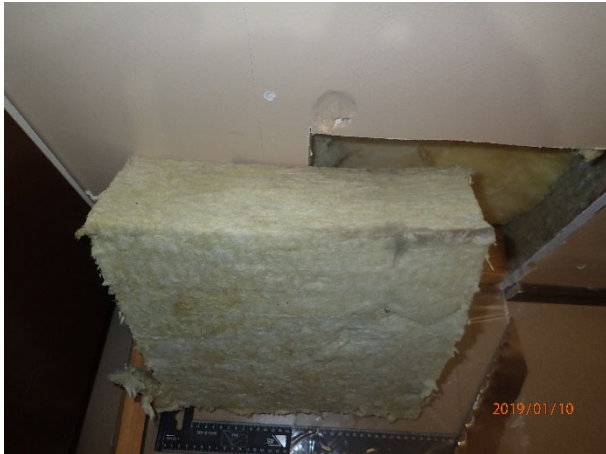
Kuva 4. Ulkoseinän mineraalivilla oli aistinvaraisesti hyväkuntoinen
