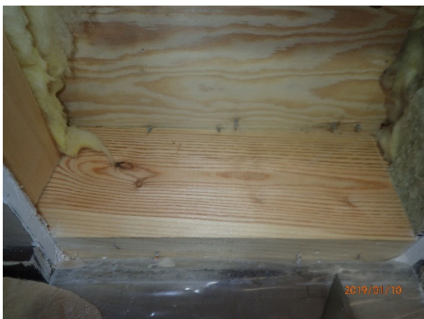
Kuva 6. Tuulensulkulevynä on käytetty 3...4 mm vaneria. Vanerin sisäpinta oli aistinvaraisesti hyvässä kunnossa
