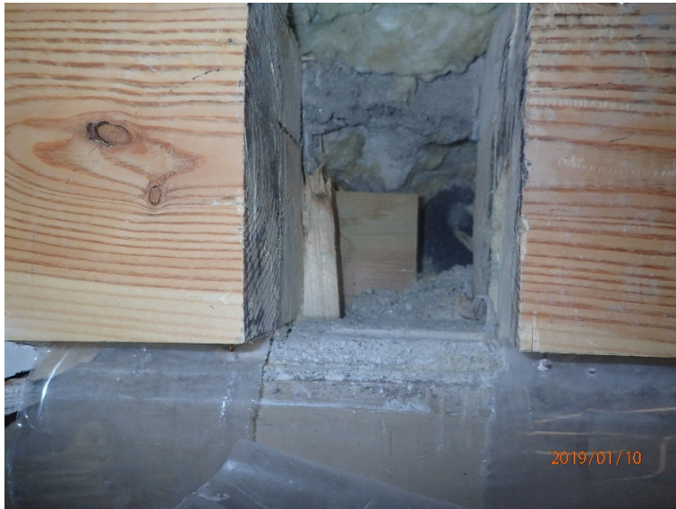
Kuva 13. Perusmuurin päälle sijoitettu kermieriste, kestopuisia korotuspaloja ja mineraalivillaa.
