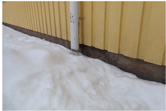
Kuva 17. Perusmuurin vaurioita. Sadevesisysteemin kohdalla sadevesi saattaa kuormittaa perusmuuria ja seinärakenteita
