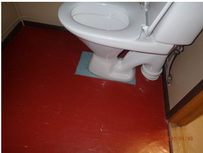
Kuva 31. Paikallisesti korjattu wc-istuimen alusta.
