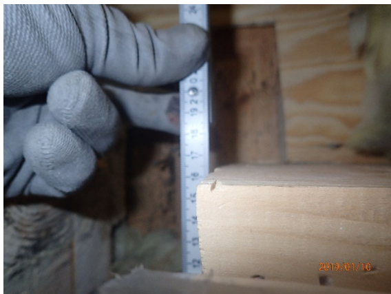
Kuva 14. Etäisyys kermin päältä lattiapintaan n. 140 mm.
