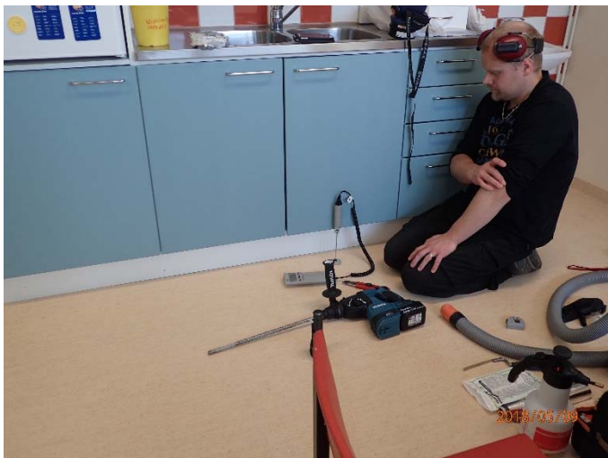
Kuva 19. Eristetilän kosteusmittaukset käynnissä.
