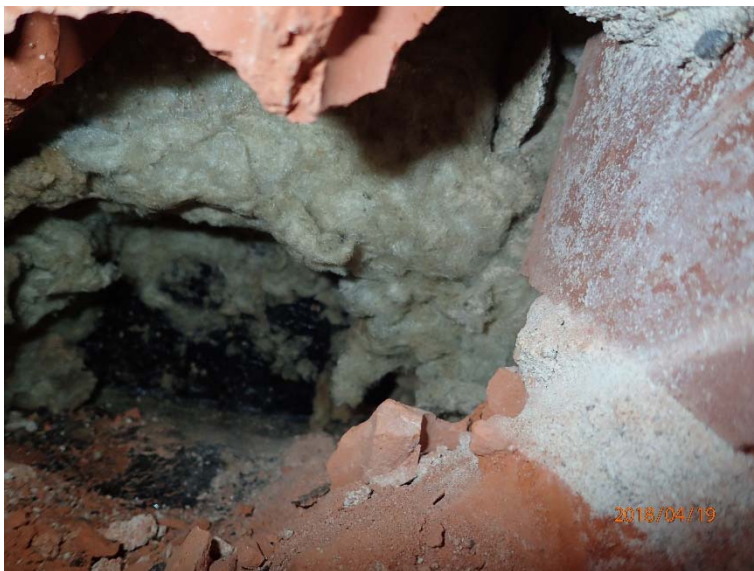
Kuva 7. Kellarin rakenneavauskohta RA1.
