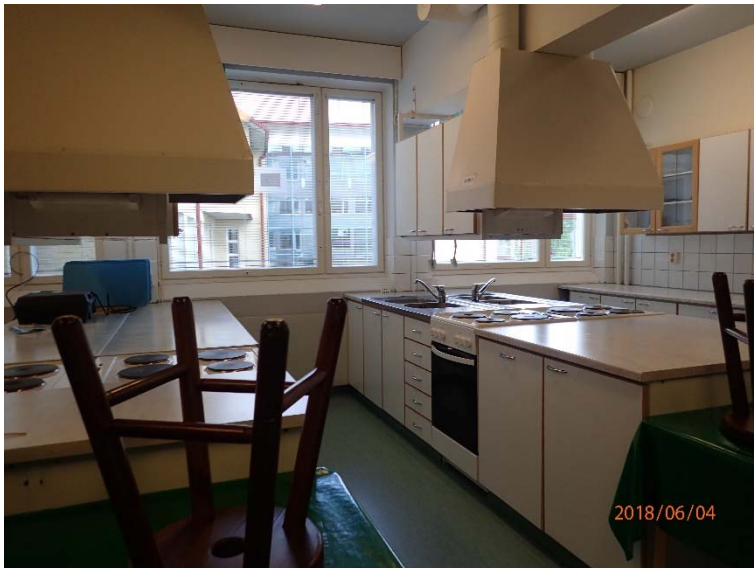
Kuva 23. Tilan paine-eroa mitattaessa havaittiin tilan olevan ajoittain jopa -40 Pa alipaineinen ulkoilmaan nähden.
