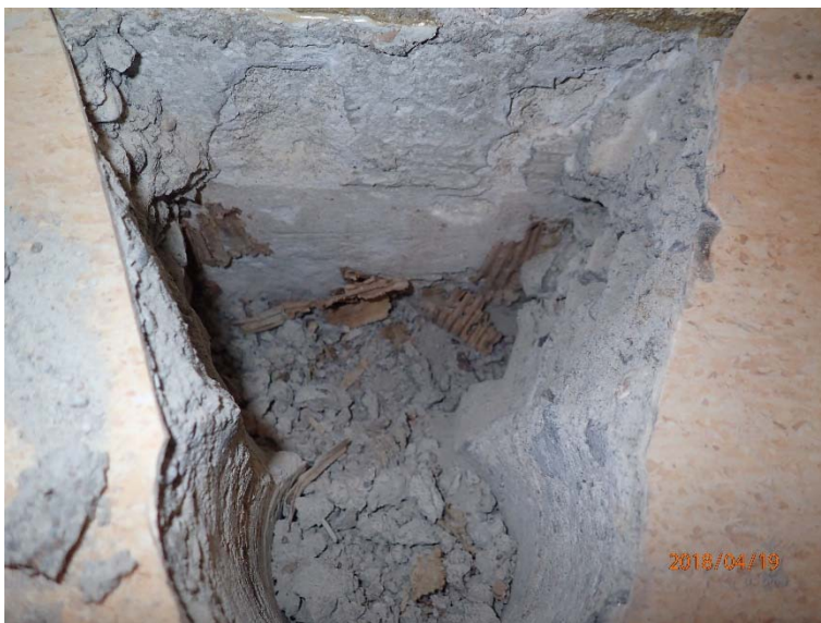
Kuva 16. Kuraattorin huoneeseen ulkoseinän läheisyyteen tehty rakenneavaus
