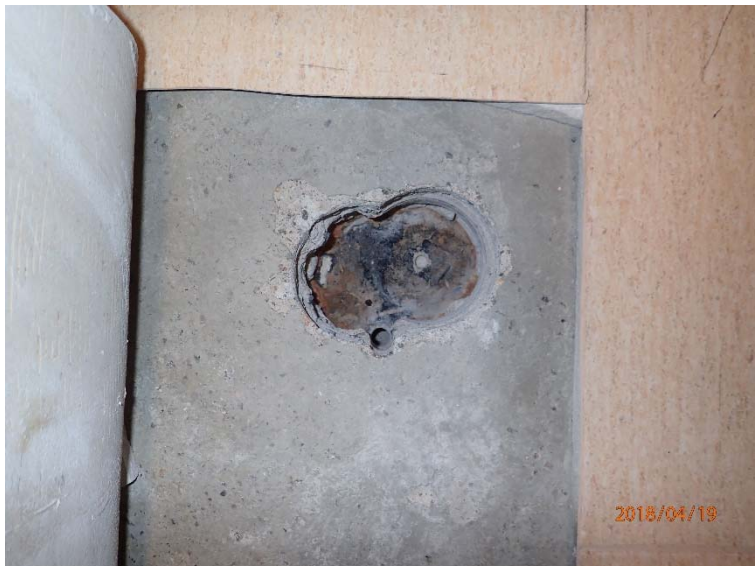
Kuva 17. Perkaustilan rakenneavauskohta. Kuvassa tasoitekerros poistettu ja näkyvillä perkaustilan alkuperäinen lattiapinta.
