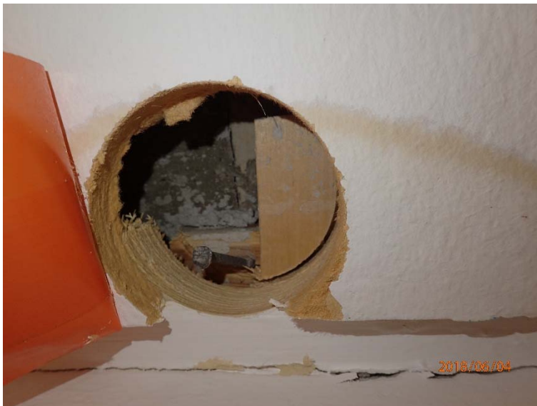
Kuva 9. Toteutettu alakattorakenne.
