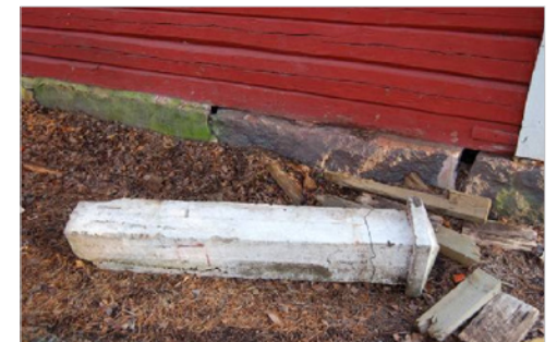
Portinpylväs on piharakennuksen takana vuonna 2008.
