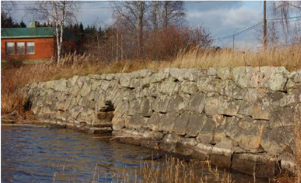
Suotaipaleen silta on yksiaukkoinen luonnon- ja lohkokivistä ladottu holvisilta. Huomaa keskellä kaunis kiilakivi. Silta on voitu perustaa karikkopohjalle.
