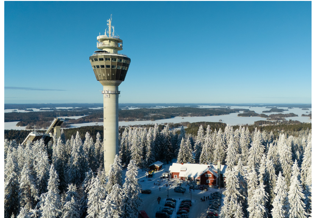
Puijon torni on näyttävä maamerkki, joka näkyy kauas. Kuva: Raimo Pesonen.
