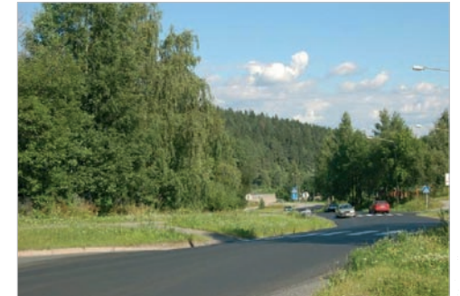
Näkymä Puijonrinteen taloille vuonna 2008
