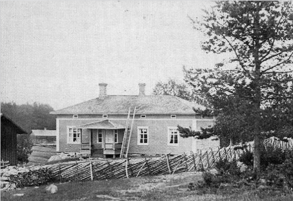
Vanha kansakoulu ennen 1920-luvulla rakennettua laajennusosaa. Kuva kyläkirjasta Kotikylämme Hirvilahti, 2005.
