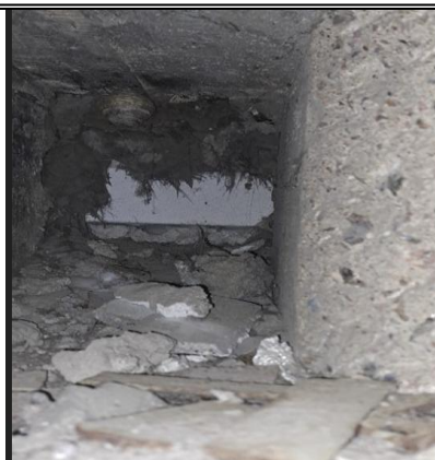
Kuva tuuletusaukon onkalosta
