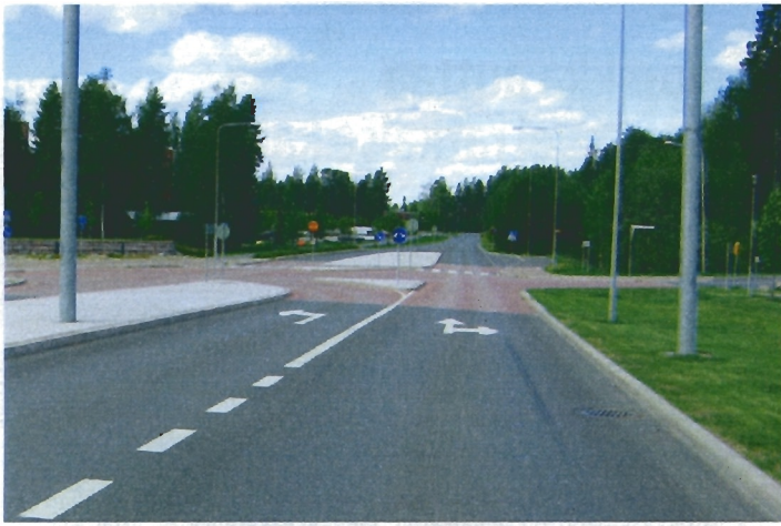
TÄMÄN suoran toisessa päässä tieltä suistuminen tapahtui. Ympäristö ei vaikuta erityisen ongelmalliselta, mutta missä tahansa voidaan ajaa hengen- vaarallisen lujaa.
