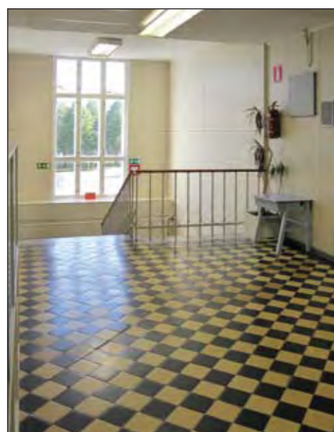
Sekä työselityksessä että ainearviossa luetaan ne tilat, joihin tulee lankkulattia, ja muut tilat mainitaan pinnoitettaviksi sementtilevyillä. Sementtilevyillä tarkoitetaan ilmeisesti keraamisia laattoja, joilla ainakin päällysvaatehuoneiden ja porrastasojen lattiat pinnoitettiin. Anna-Leena Lehto 2010, Keski-Suomen museo.
