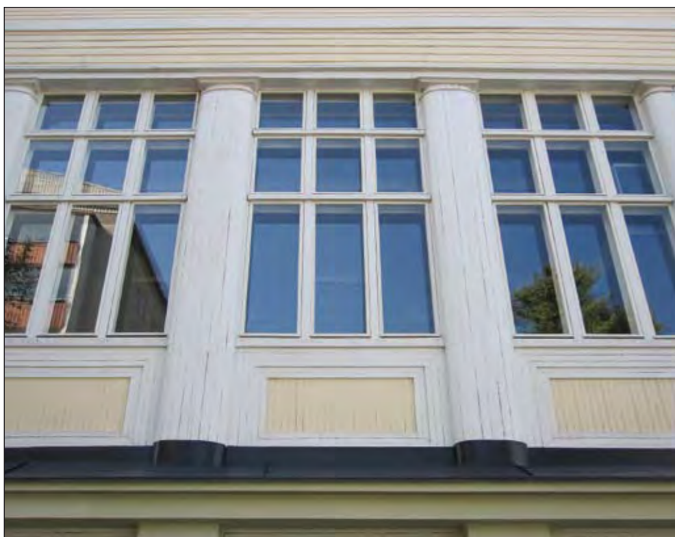
Ainonkadun puolella toteutettiin jo rakennusvaiheessa toisen kerroksen puolipylväät ja ikkunoiden alapuoliset suorakulmiodeltaljit. Päätökolmio vuorattiin heti, mutta toisen kerroksen hirsirakenne jätettiin paljaaksi, jotta se saisi painua ennen vuoraamista. G. A. Stoorre, Keski-Suomen museon kuvaarkisto.
