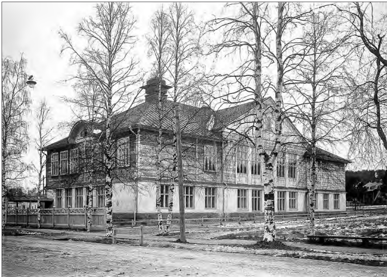
Ainonkadun puolella toteutettiin jo rakennusvaiheessa toisen kerroksen puolipylväät ja ikkunoiden alapuoliset suorakulmiodeltaljit. Päätökolmio vuorattiin heti, mutta toisen kerroksen hirsirakenne jätettiin paljaaksi, jotta se saisi painua ennen vuoraamista. G. A. Stoorre, Keski-Suomen museon kuvaarkisto.
