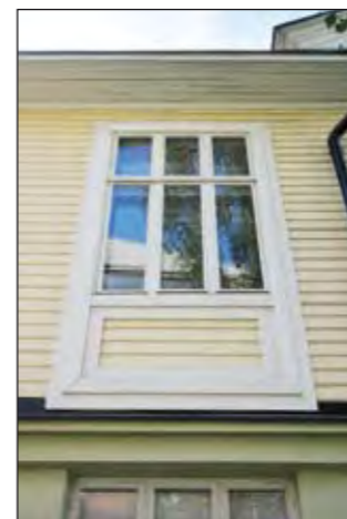
Toisen kerroksen julkisivut verhoitiin vaakaponttilaudoituksella vuosien 1920–1924 välisenä aikana. Anna-Leena Lehto 2010, Keski-Suomen museo.
