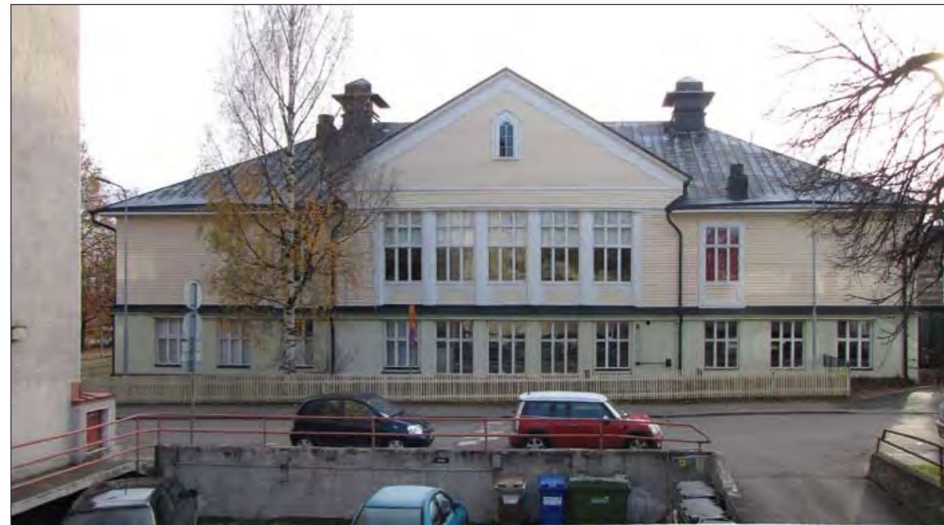
Toisen kerroksen julkisivut verhoitiin vaakaponttilaudoituksella vuosien 1920–1924 välisenä aikana. Anna-Leena Lehto 2010, Keski-Suomen museo.
