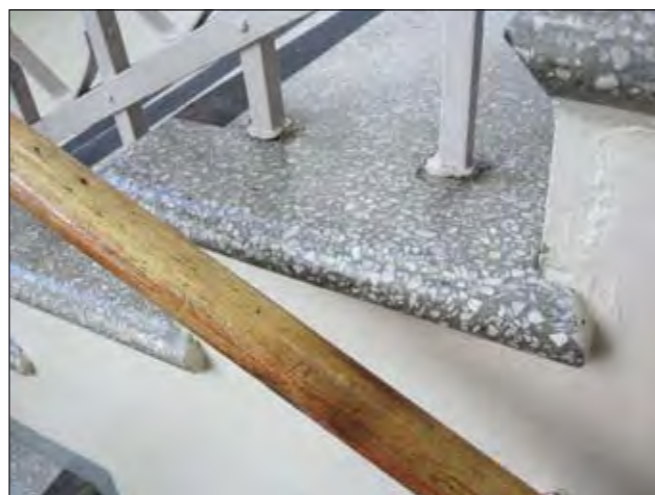
Kuvat yllä: Kellariin johtavat porrasaskeleet tehtiin ainearvion määräyksen mukaisesti sementistä. Pääoven rappusten sekä ensimmäisen ja toisen kerroksen välisten portaikkojen porrasaskeleet tehtiin ”sementtimosaikista” eli mosaiikkibetonista. Anna-Leena Lehto 2010, Keski-Suomen museo.
