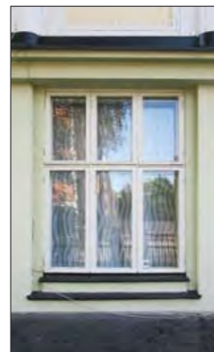
Ikkunoihin liittyvät listoitukset toteutettiin vasta julkisivujen vuoraamisen yhteydessä 1920-luvun alussa. Silloin ne toteutettiin piirustuksiin nähden hieman yksinkertaistetussa muodossa. Alakeran muuriin toteutettiin kanslian ja opettajainhuoneen ikkunoiden ympärille sisennykset ja alapuolelle porrastukset. Niissä ei kuitenkaan toteutettu piirustusten mukaista vaakasuuntaista detaljia. Anna-Leena Lehto 2010, Keski-Suomen museo.
