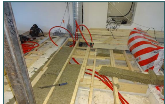
Luokkatilan altaan vesijohdot on asennettu.
