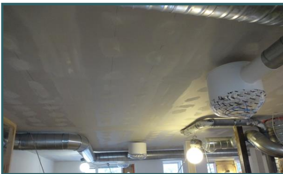
Katon tasoitus on käynnissä.
