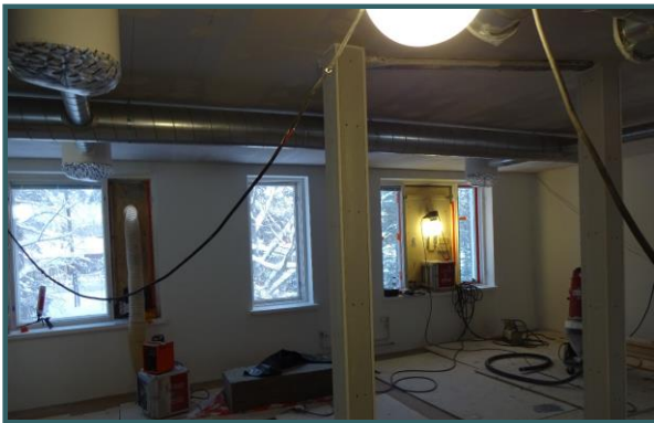
Kantava teräspalkkisto paloeristetään levyttämällä.
