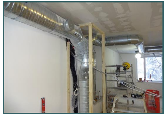
Pääosa tilan iv-kanavistosta uusitaan.
