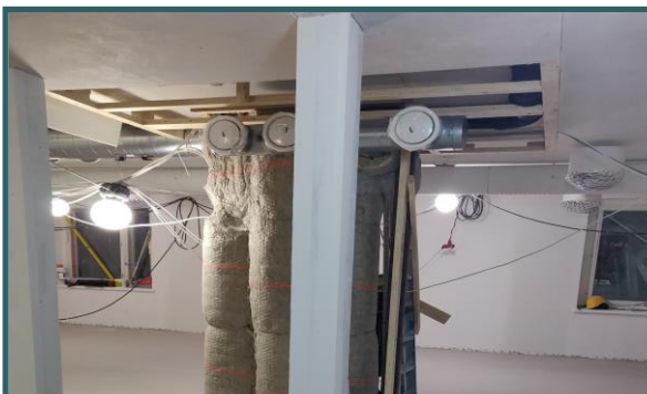
Ennen lattian matotusta pinta tasoitettiin. Iv-putket eristettiin ennen kotelointia.
