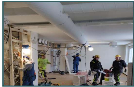
Työmaan työturvallisuuteen on kiinnitetty erityishuomiota koko projektin ajan.
