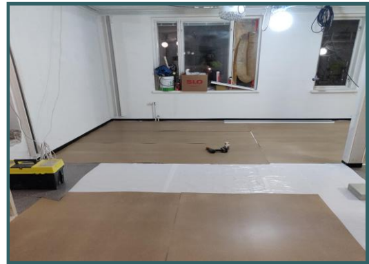
Uusi muovimatto suojattiin lopputöiden ajaksi.
