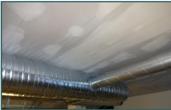
Uudet iv-putket maalataan valkoisiksi.
