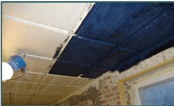
Jälkimmäinen Plowerproof kerros muuttuu kuivuuksaan sinisestä mustaksi.
