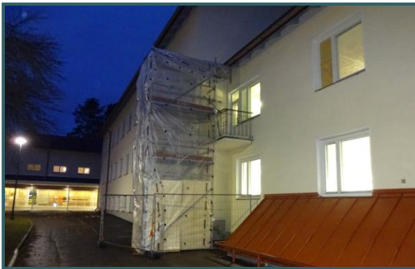
Työmaakulku on porrastornin kautta ja tavaraliikenne ikkunoista.
