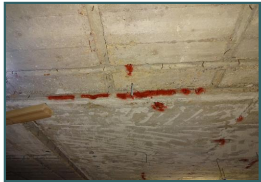
Kattopinnan avoimet teräkset puhdistettiin ja ruosteenesto käsiteltiin, ennen niiden paikkaamista umpeen.
