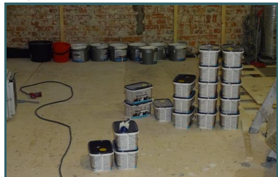
Ensimmäinen ja toinen katon tiivistys kerros tehdään laadun varmistamiseksi eri värisillä aineilla.
