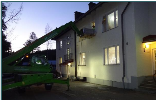
Suuremmat tarvike-erät on porrastornin sijaan nostettu sisään työmaa-alueen ikkunasta kurottajalla.
