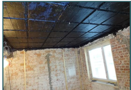
Oikea tasoitepaksuus varmistetaan ohjureilla, jotka poistetaan tasoittamisen jälkeen ja kolo paikataan.
