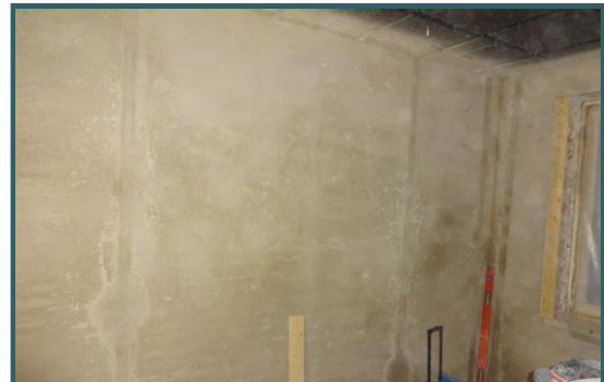
Ruiskutasoitettun pinnan seuraava työvaihe on Ardex F5 verkkotasoitus.
