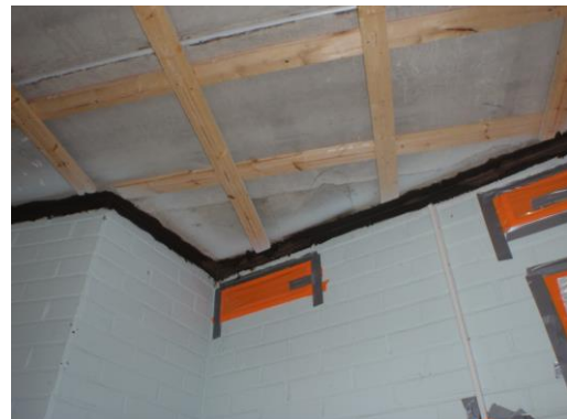
Rakenneliittymien tiivistykset
