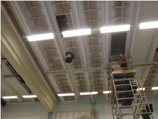
Liikuntasalin akustolevyjen vaihto Läpivientien tiivistykset
