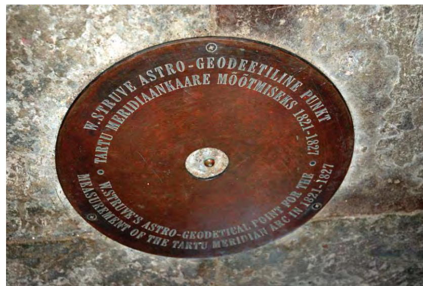
Tarton observatorion vieressä on tähtitorni, jota Struve käytti havainnointiinsa 1800-alkupuolella (yllä). Observatorion lattiassa on mittauspiste, joka määritettiin vuosina 1821-27. (alla)
