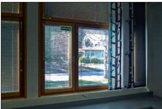
Kuva 9. Pakenemisikkuna, jossa ovat kiintokahva ja varatiemerkintä. On otettava huomioon etteivät pienet lapset pääse omin päin avaamaan ikkunaa. (kuva: Mikko Helasvuo)
