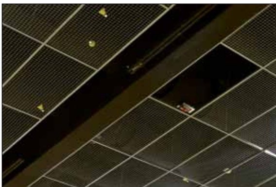
Kuva 5. Liikuntasalin vaarallinen alakatto, jonka yksi verkkoelementti on pudonnut. Pallot jäävät verkkoelementin päälle. (kuva: Mikko Helasvuo)
