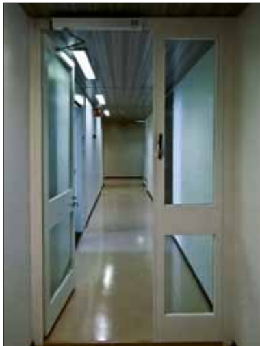
Kuva 16. Savusta sulkeutuvalla ovipumpulla varustettu osastoiva ovi. (Kuva: Pekka Rajajärvi)
