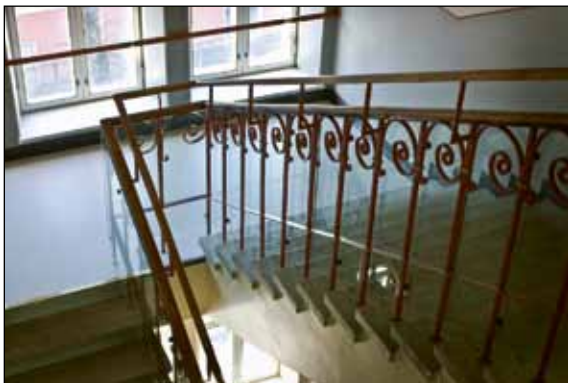
Kuva 8. Esimerkki historiallisesti arvokkaan kaiteen turvallisuuden parantamisesta lisäkaiteella ja lasilevyllä. (kuva: Mikko Helasvuo)
