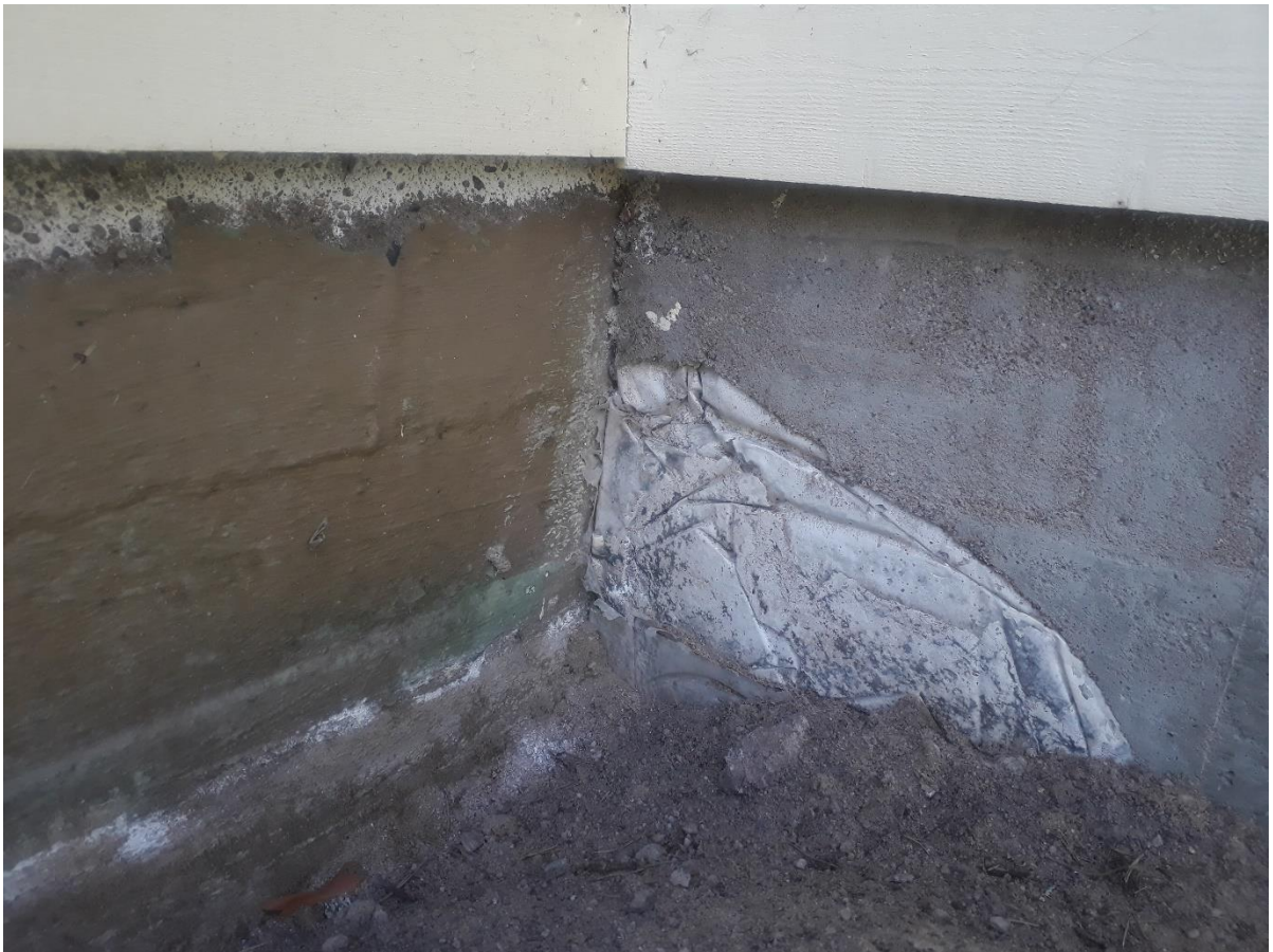
Kuva 4. Näkyvä lännen puoleisesta uuden ja vanhan osan saumakohdasta.
