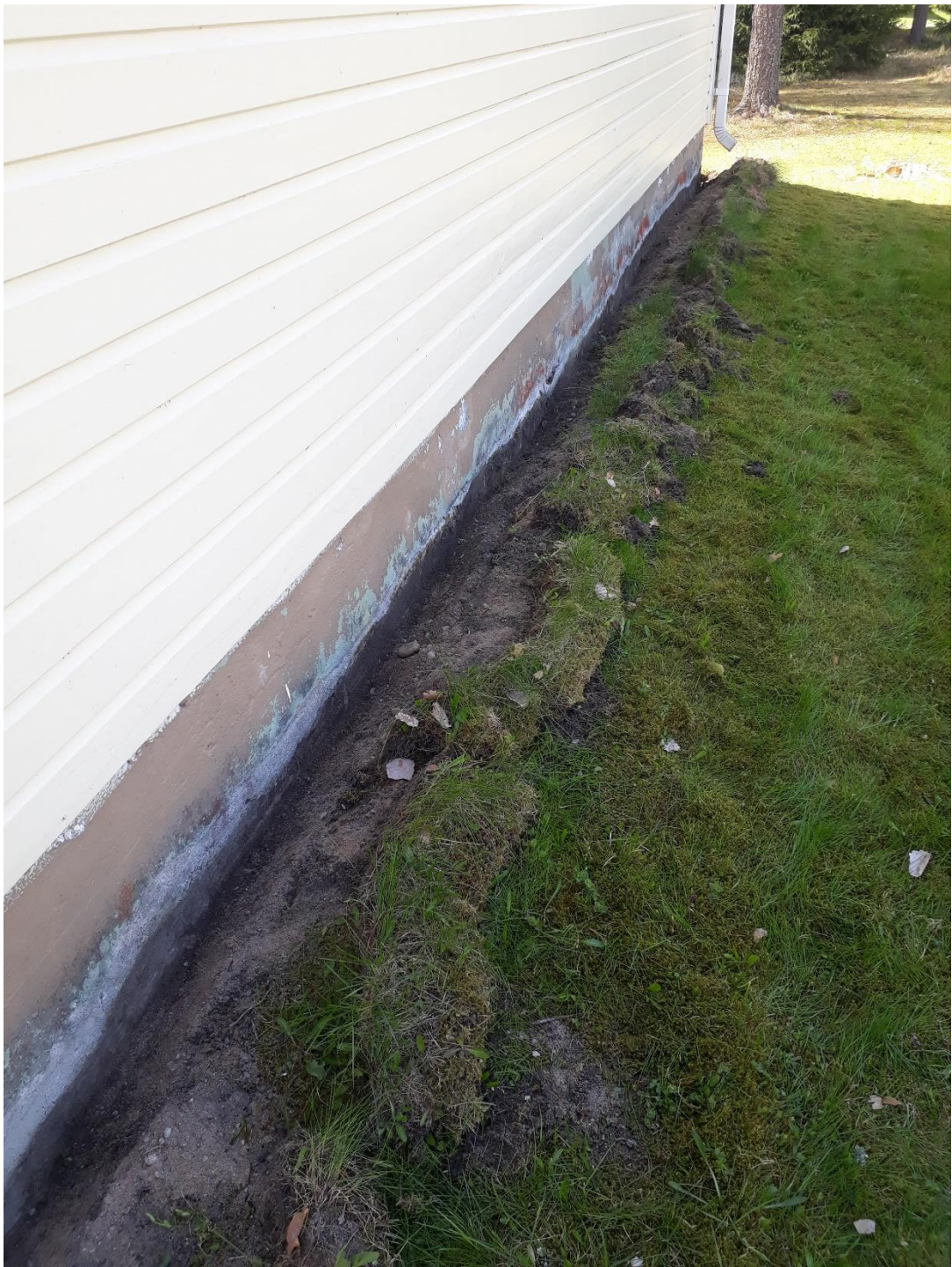
Kuva 10. Pintamaa poistettuna lännen puolelta.
