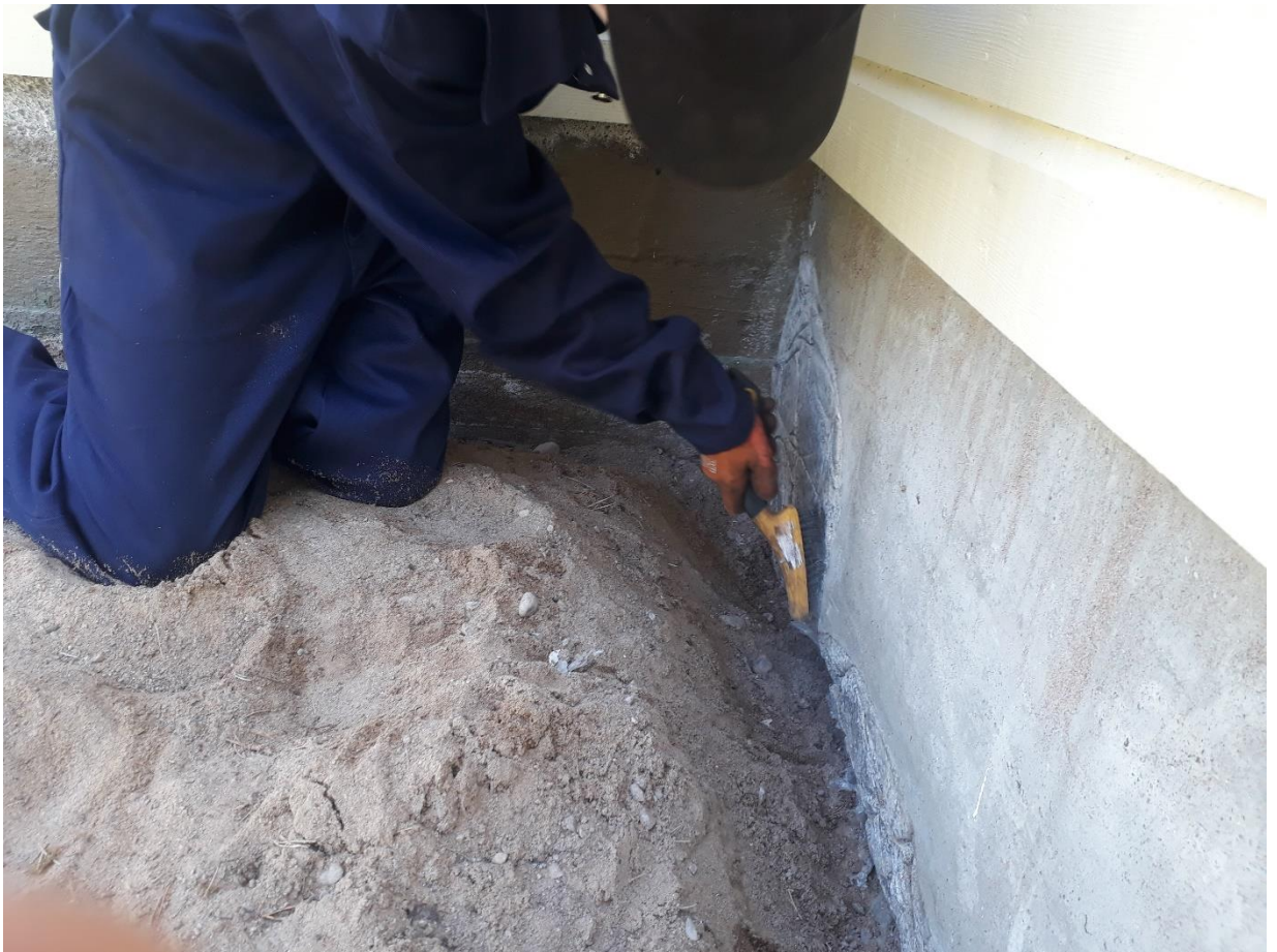
Kuva 11. Valuvirheen korjaamisen valmistelu puhdistuksella 26.5.2020.
