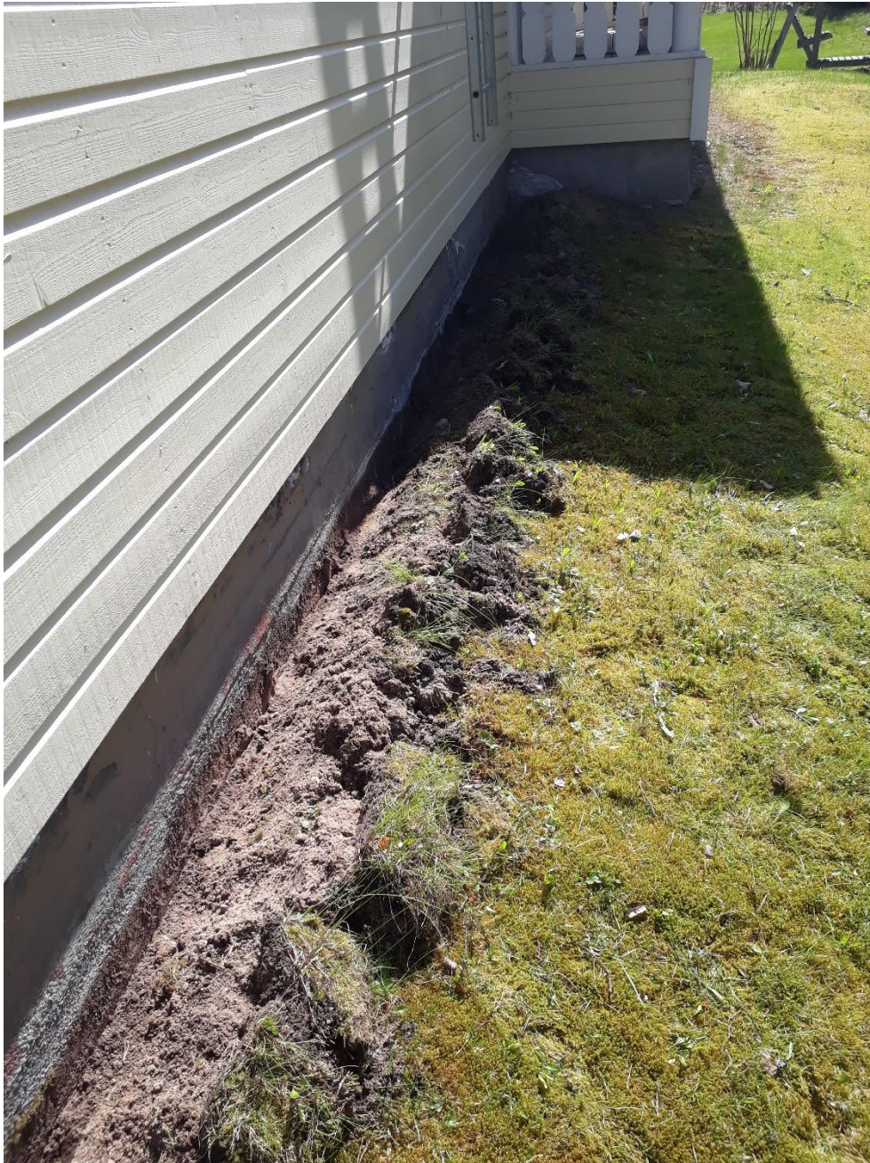
Kuva 8. Pintamaa poistettuna lännen puolelta.
