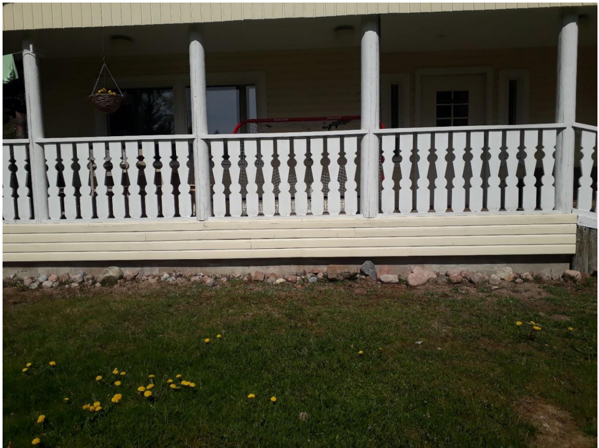
Kuva 5. Näkymä radan suunnasta kiinteistön uuden osan sokkelista.
