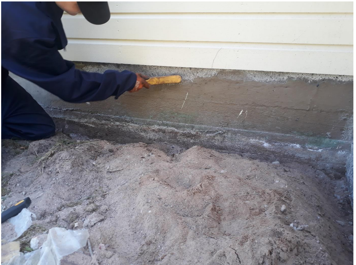
Kuva 12. Rapautumien korjaamisen valmistelu puhdistuksella 26.5.2020.
