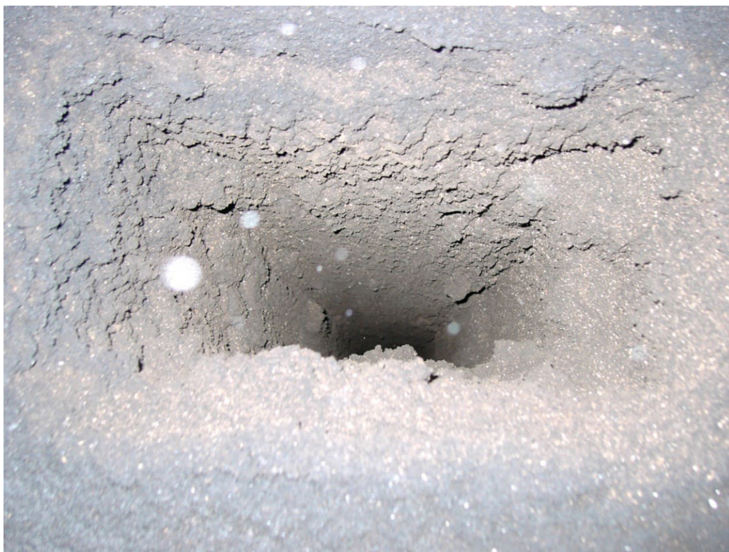
Hormeja ennen puhdistusta
